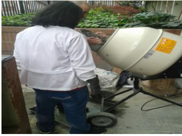
Fotografía 13. Preparación de mezcla en el trompo. Tomado 27 de Febrero de 2015.
