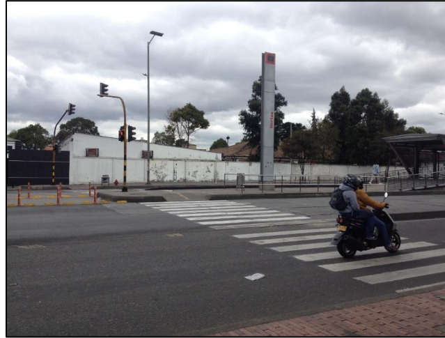
Ilustración 19. Estación Hortua (Carrera. 14 con calle 2 sur)
