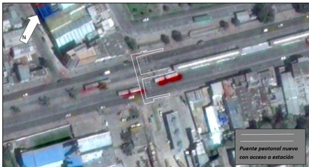
Ilustración. 28 Puente peatonal. Estación Calle 40 sur (Carrera. 14 con calle 41 b sur)
