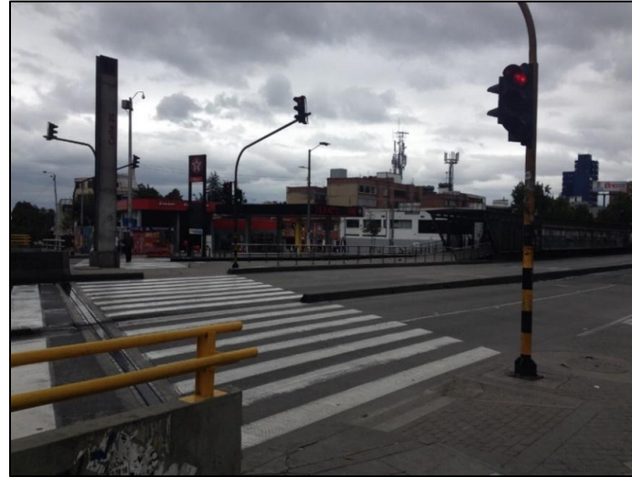
Ilustración 23. Estación Calle 26 (Carrera. 14 con calle 25)
