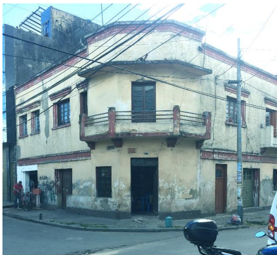
Figura 2: Inmueble patrimonial en condición de deterioro. Fuente: Elaboración propia.
