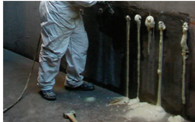
Foto 31. Aplicación de inyecciones de poliuretano SikaFix HH
