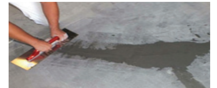
Foto 23. Reparación de juntas mediante el uso de morteros.
