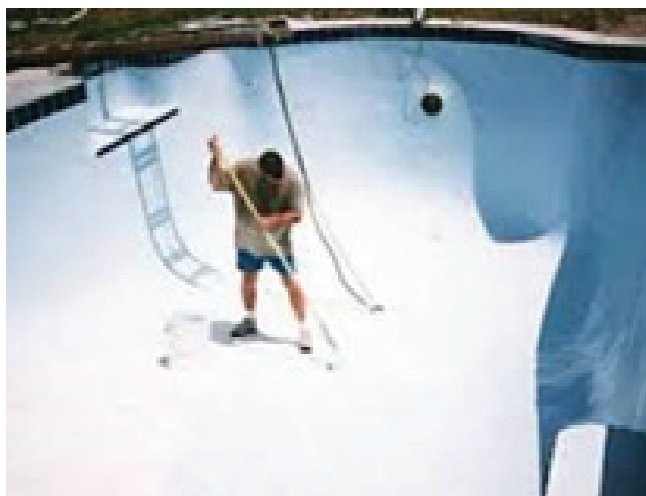
Foto 8. Impermeabilización de piscina con materiales epóxicos.
