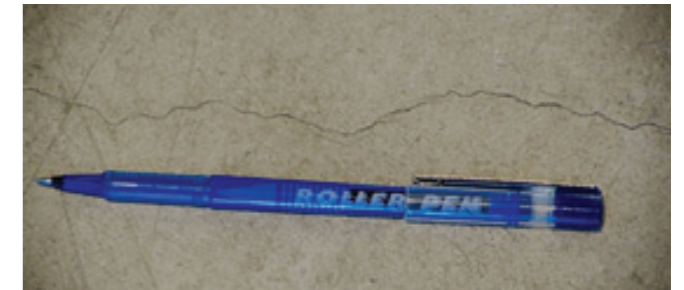
Foto 14. Fisuras en superficie de concreto
