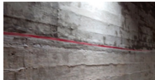
Foto 29. Sello de junta en tanque mediante Sikadur®-Combiflex®SG.
