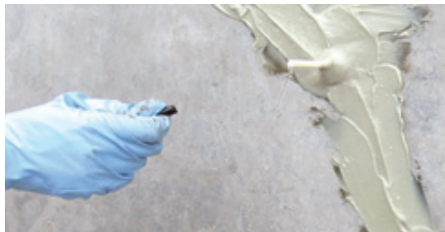
Foto 24. Aplicación de inyecciones de poliuretano.
