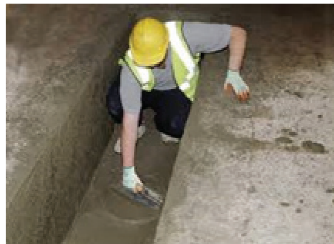
Foto 9. Impermeabilización de tanque con materiales cementantes.
