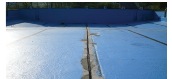
Foto 16. Juntas presentes en la superficie de una piscina
