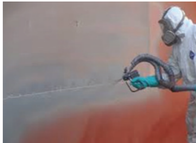
Foto 10. Impermeabilización de tanque con poliurea
