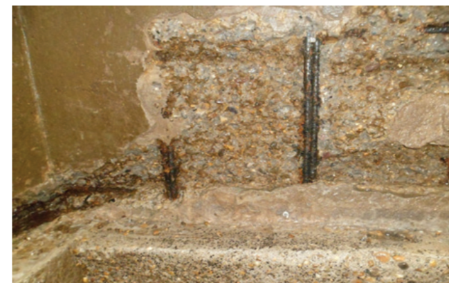
Foto 27. Abujardado en superficie de concreto
