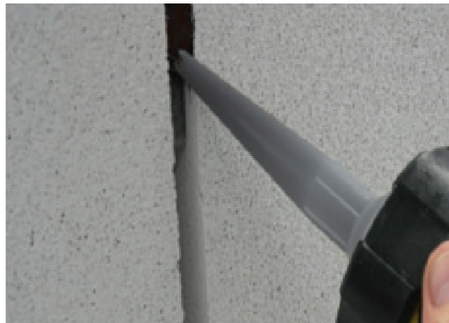
Foto 4. Aplicación de masilla en junta
