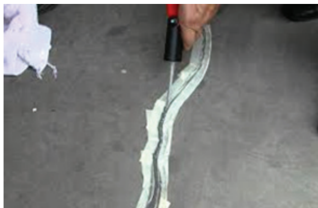
Foto 26. Aplicación de masilla
