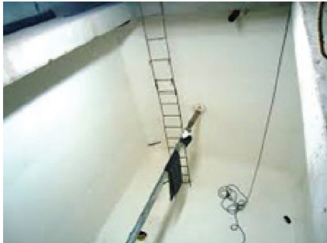
Foto 7. Impermeabilización de tanque mediante membrana de PVC.
