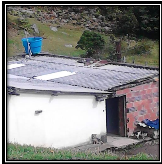
Figura 11. Tanque de almacenamiento sobre de las viviendas en Peña Blanca.
