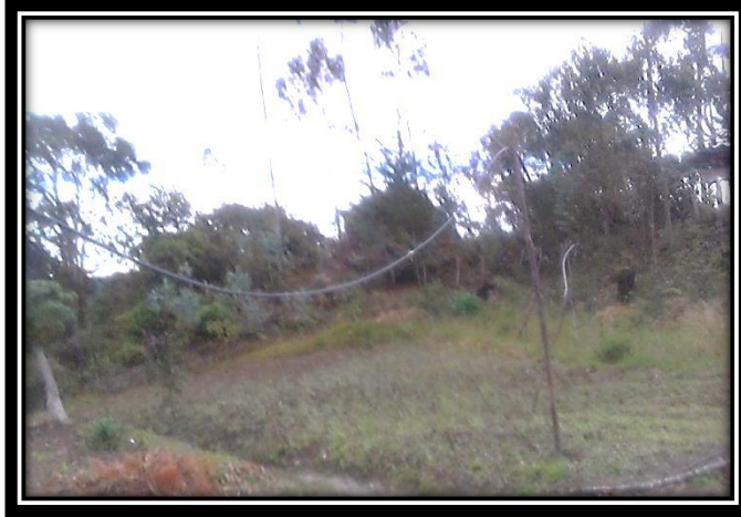
Figura 10. Mangueras procedentes de los pozos profundos.
