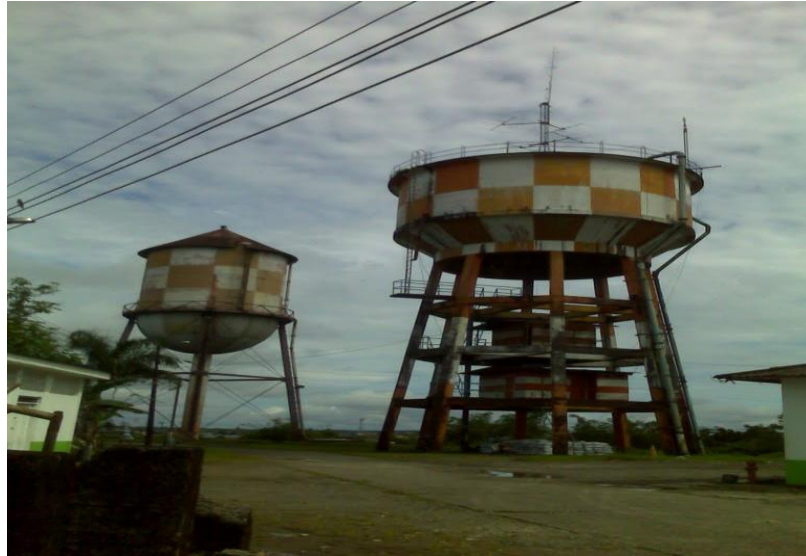
Figura 4. Acueducto municipal de la ciudad de Quibdó
