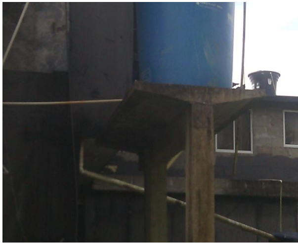
Figura 32. Forma de captación de agua lluvia en tanques
