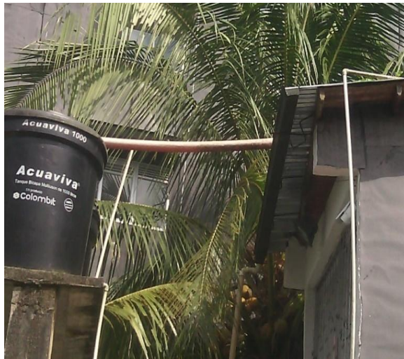
Figura 33. Forma de recolección de aguas lluvias técnica por tubería
