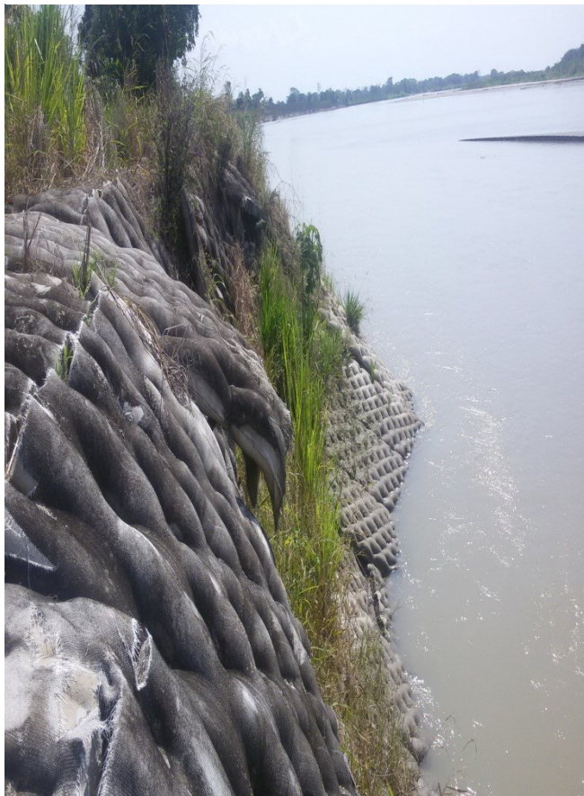
15 DESTRUCCION DEL MURO DE CONTENCIÓN POR FENOMENO NATURAL
