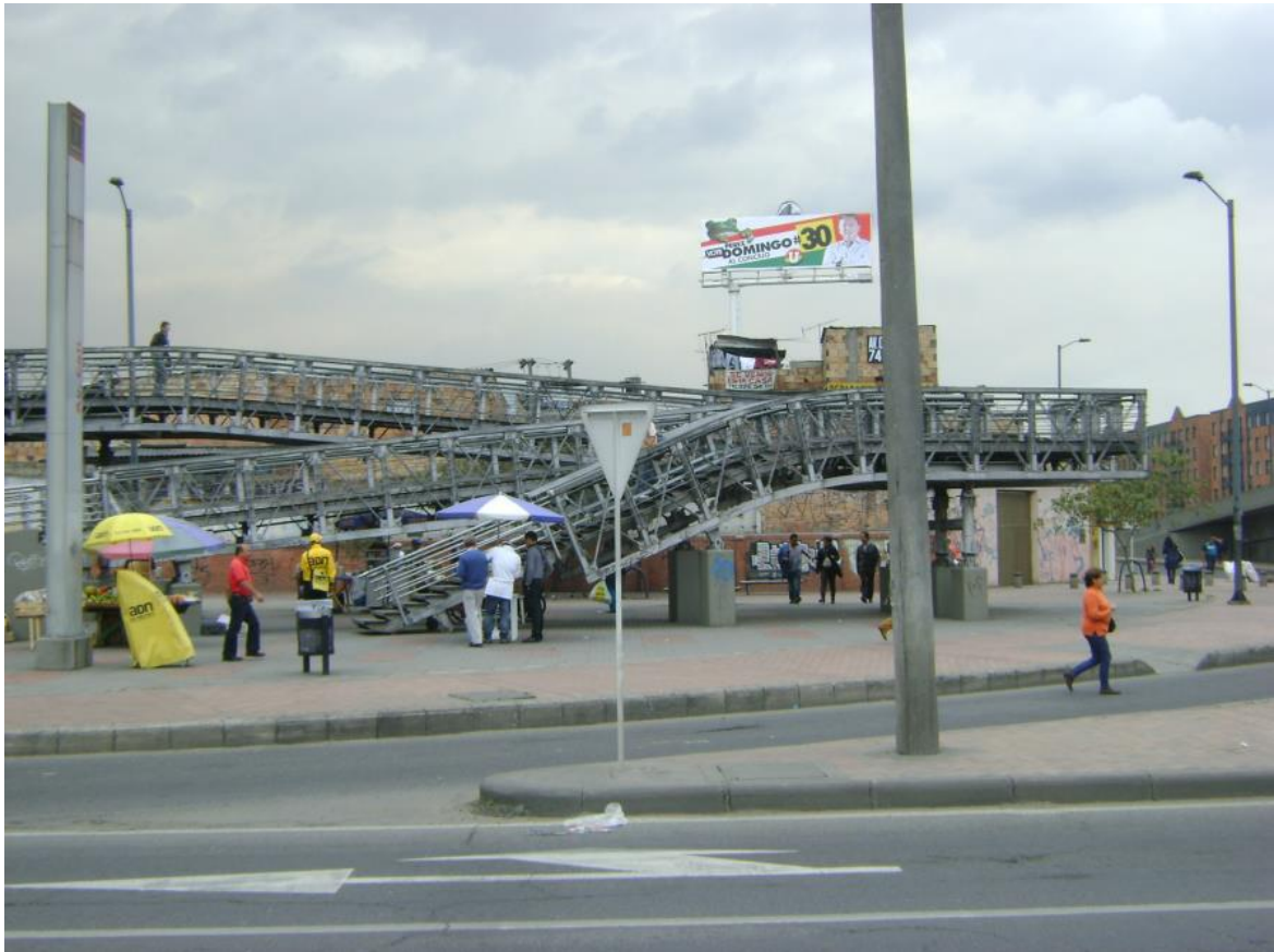
Figura 21: Arranque puente peatonal Estación TM Avenida Cali
