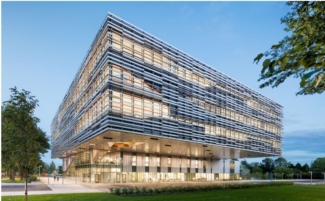
Ilustración 29. Edificio Lángara de Ciencia y Tecnología.
