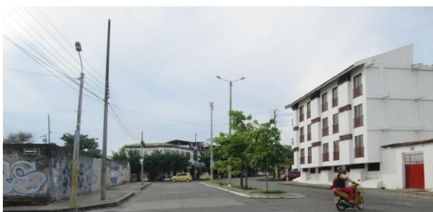
Registro fotográfico 7 Fuente: propia 2018
