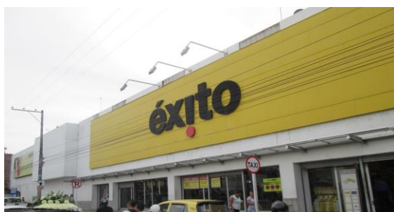
Registro fotográfico 9 Fuente: propia 2018
