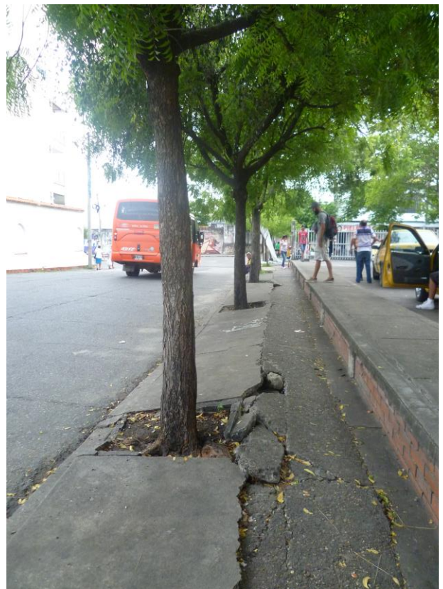
Registro fotográfico 21 Fuente: propia 2018
