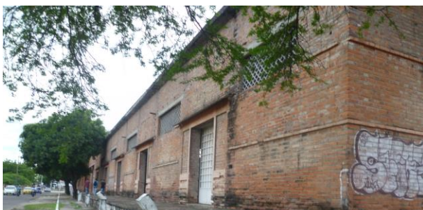
Registro fotográfico 22 Fuente: propia
