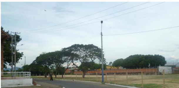
Registro fotográfico 20 Fuente: propia 2018
