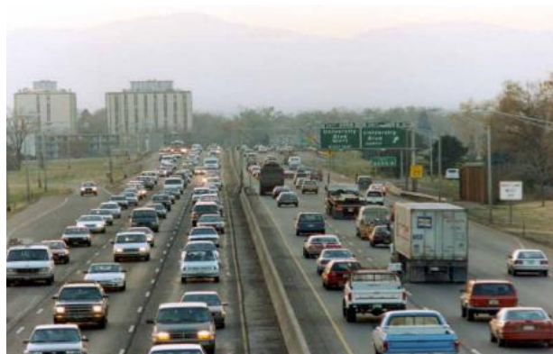
Fotografía No. 2. Cargas que se pueden encontrar en la actualidad sobre una carretera. (Consejo de directores de carreteras de Iberoamérica 2002).
