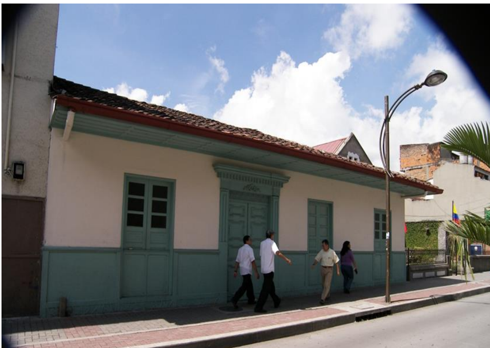
Imagen 8. Casas patrimoniales en Manizales, restauración
