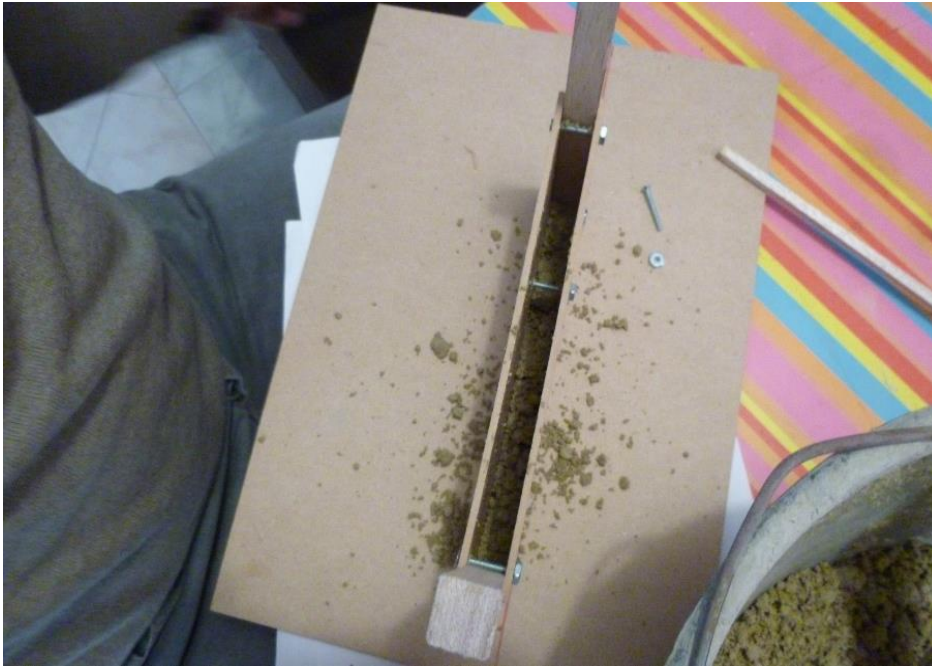
Imagen 25. Vertir tierra en el encofrado
