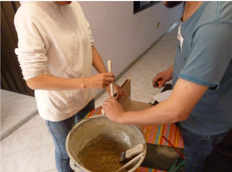
Imagen 28. Proceso de apisonamiento segundo tramo
