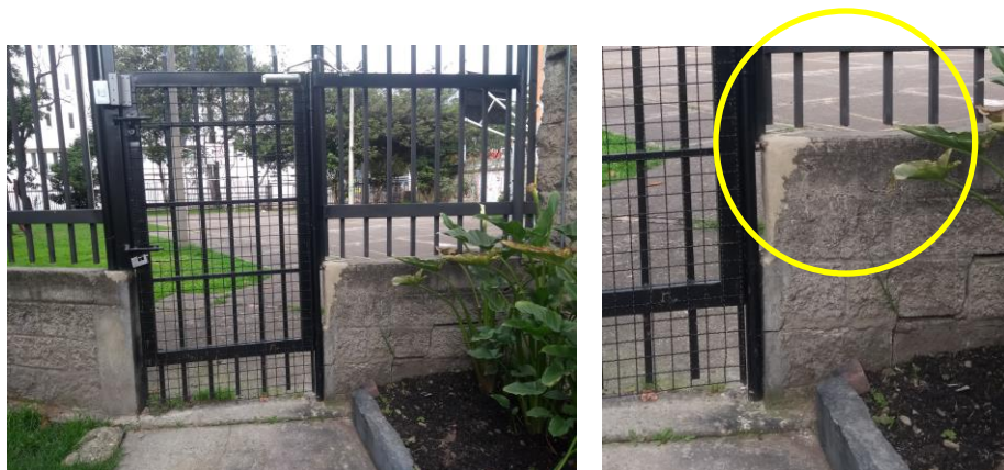
Imagen 108. Antepecho de cerramiento con presencia suciedad / Imagen 109. Nivel de clasificación de la lesión, moderada-grave
