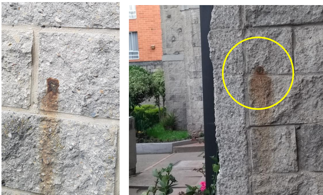
Imagen 117. Lesión física por oxidación / Imagen 118. Ensuciamiento por oxidación
