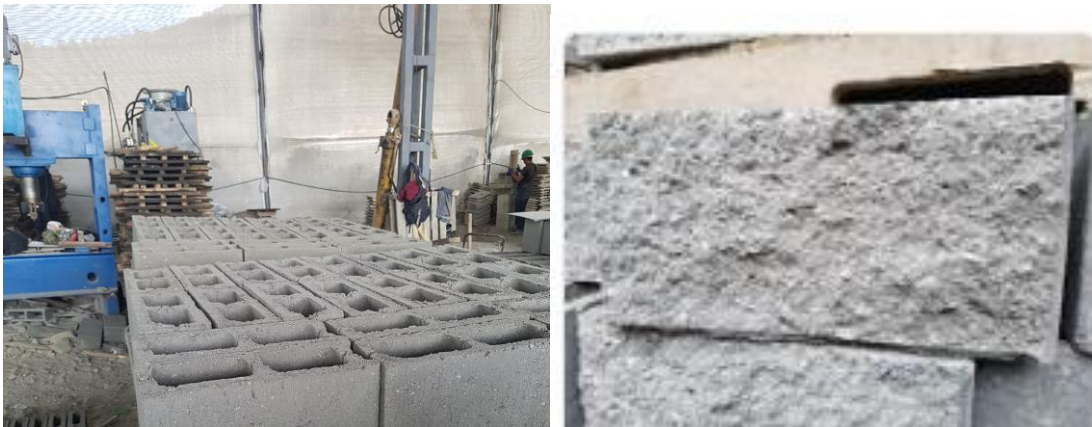
Imagen 66. Maquinaria para corte al bloque de concreto / Imagen 67. Bloque abujardado
