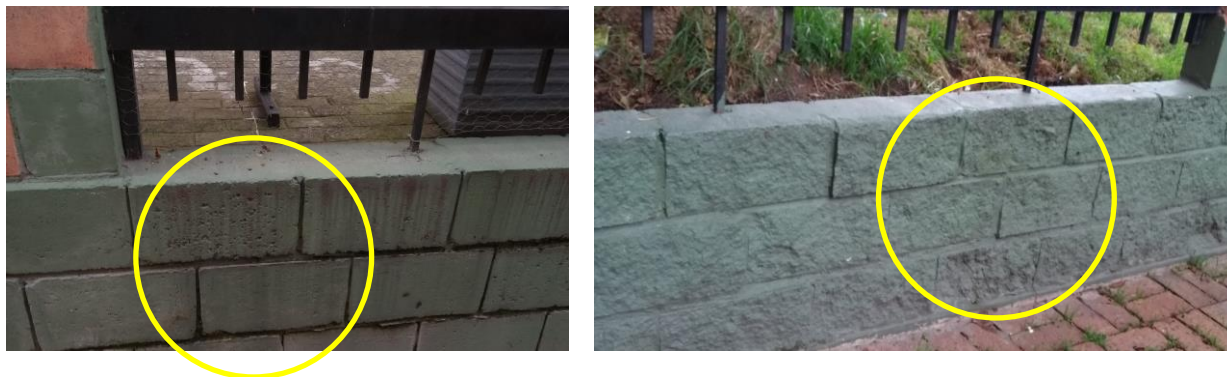
Imagen 94. Antepecho con presencia de lesión física, suciedad / Imagen 95. Antepecho de cerramiento
