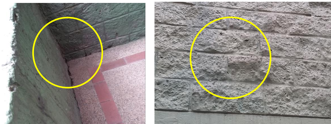
Imagen 98. Antepecho de las torres, suciedad / Imagen 99. Antepecho con presencia de erosión
