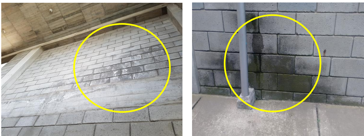
Imagen 91. Muro interno con presencia de eflorescencia blanca debido a la humedad / Imagen 92. Fachada con presencia de musgo debido a la humedad
