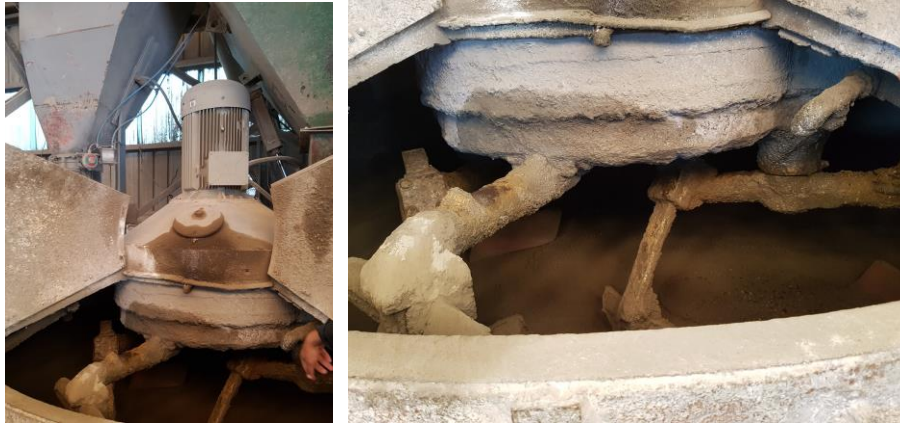
Imagen 13. Tolvas de almacenamiento de cemento / Imagen 14. Mezcladora
