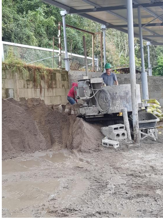
Imagen 59. Zona de mezclado de agregados para la mezcla de concreto
