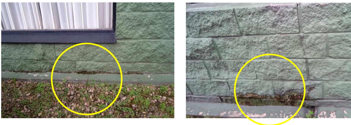
Imagen 96. Arranque de muro con presencia de musgo / Imagen 97. Lesión biológica avanzada en los bloques sin pintura
