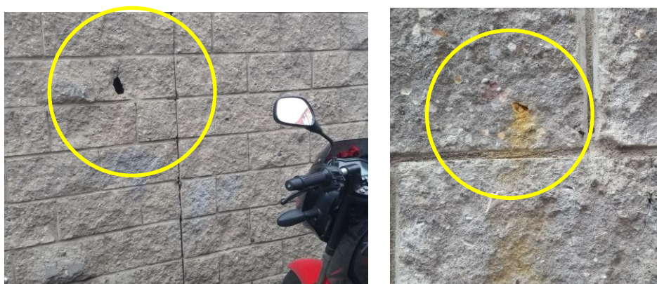
Imagen 110. Presencia de erosión en el muro de cerramiento / Imagen 111. Desprendimiento de los materiales que componen el bloque en concreto
