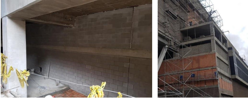
Imagen 69. Implementación bloque de concreto en sótano / Imagen 70. Implementación de bloque de concreto en fachada
