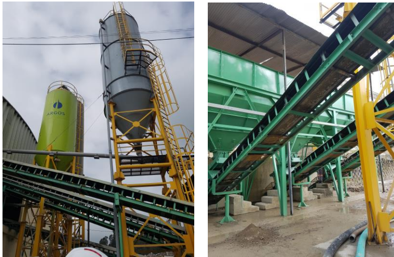
Imagen 40. Silos de almacenamiento para el cemento / Imagen 41. Bandas transportadoras de la materia prima
