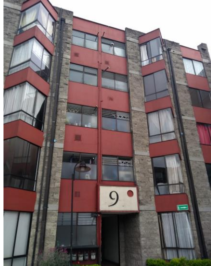
Imagen 101. Torre #9 C. Oikos Teucali
