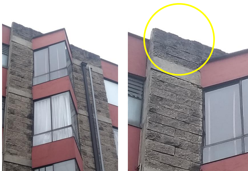
Imagen 113. Ensuciamiento en el remate de muro de fachada / Imagen 114. Lesiones físicas en muros de fachadas
