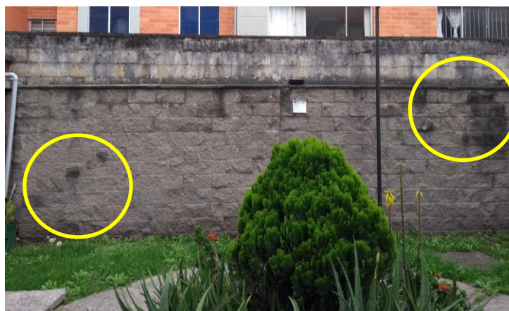
Imagen 121. Muro de cerramiento, con presencia de varias lesiones graves
