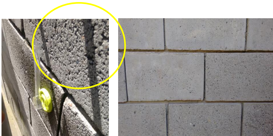
Imagen 88. Muro con presencia de lesión física, erosión, desprendimiento del material / Imagen 89. Muro en bloque de concreto
