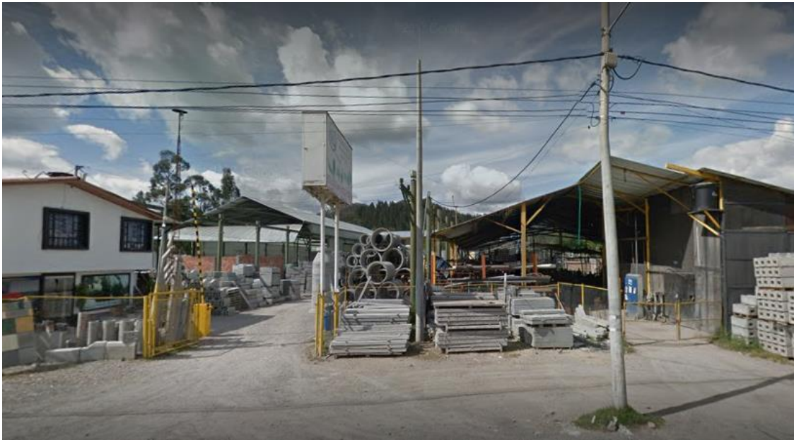
Imagen 57. Fachada de fábrica N° 3
