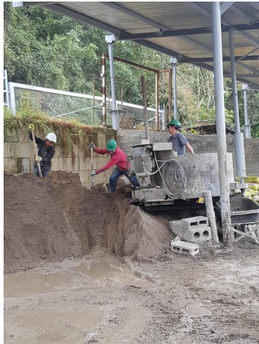
Imagen 58. Zona de almacenamiento de agregados para la formación de la mezcla
