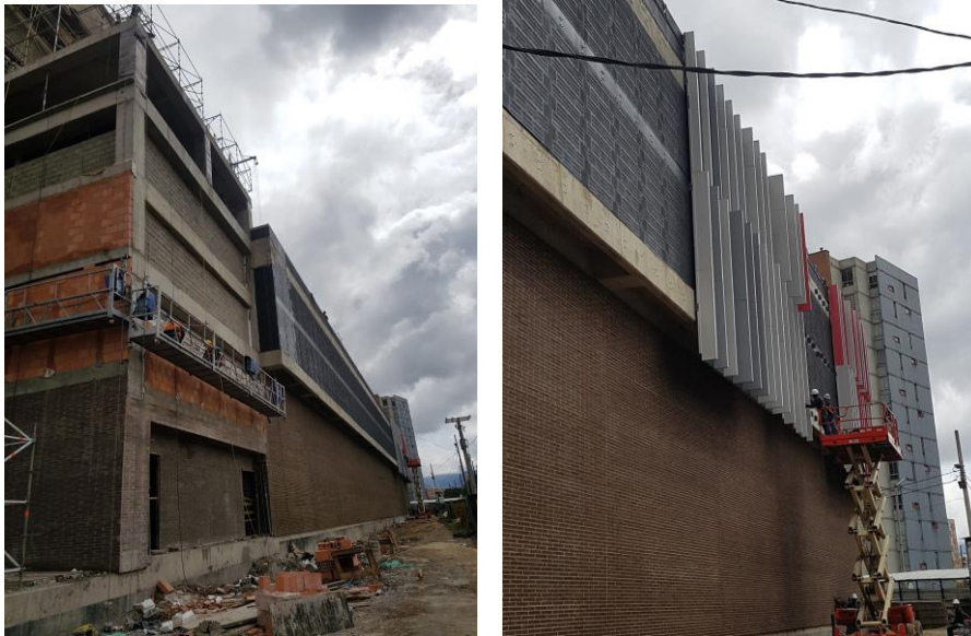
Imagen 73. Fachada con sistema constructivo doble muro / Imagen 74. Fachada cinética
