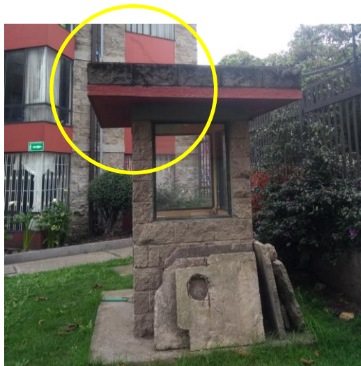
Imagen 112. Caseta de vigilancia ubicada en el lado posterior del conjunto, con presencia de suciedad en el remate de la cubierta
