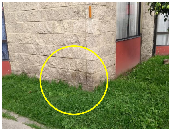
Imagen 116. Ensuciamiento en el arranque de muro de las fachadas en las torres
