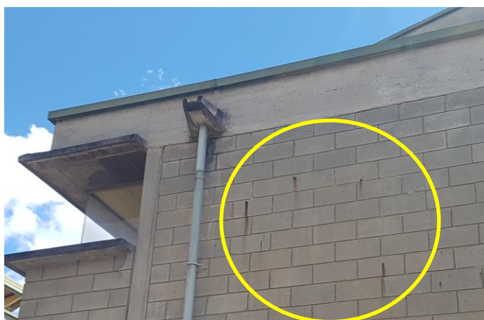
Imagen 90. Fachada con gárgola (tubería), presencia de manchas por oxidación
