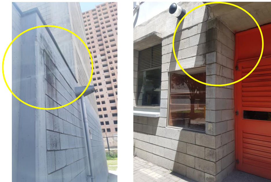
Imagen 86. Muro fachada, con presencia de suciedad / Imagen 87. Fachada salones de clase con presencia de ensuciamiento en el remate de muro
