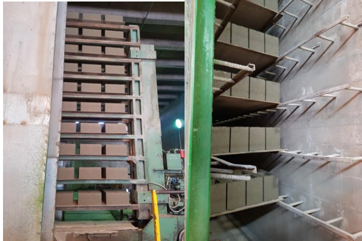
Imagen 23. Ingreso del material / Imagen 24. Cuartos de curado por vaporización
