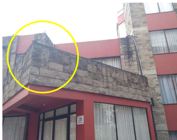
Imagen 115. Ensuciamiento en el remate de antepecho en el salón comunal del C. Oikos Teucali
