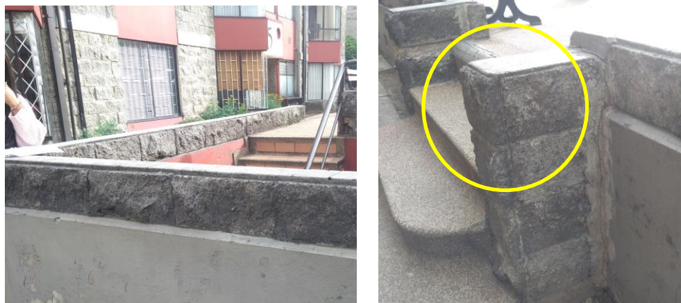
Imagen 119. Presencia de eflorescencias blancas / Imagen 120. Bloque con un nivel moderado de eflorescencias
