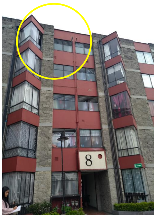
Imagen 107. Torre #8 con presencia de suciedad en el remate de muro
