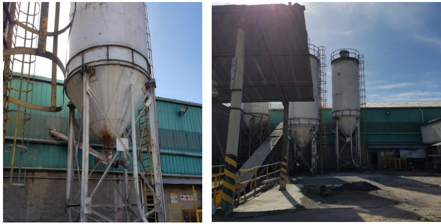
Imagen 4. Silos de almacenamiento / Imagen 5. Silos de almacenamiento cemento tipo Portland I
