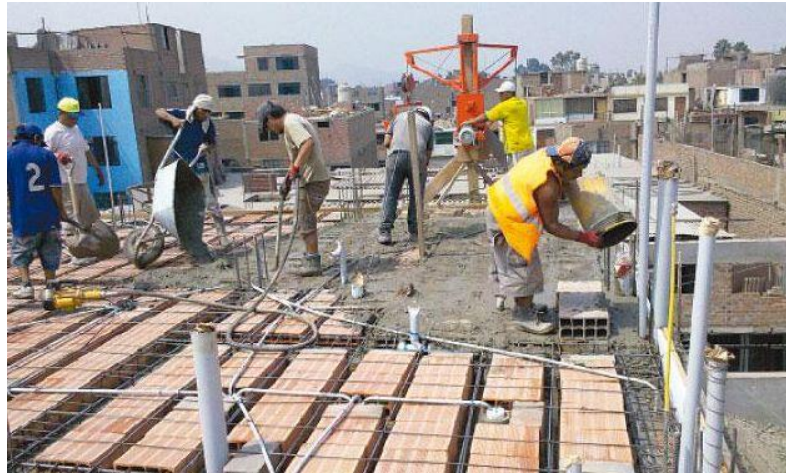
Imagen 6- Falta de elementos de protección
