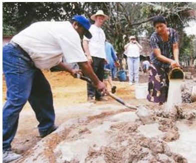
Imagen 4- Mala práctica en obra
