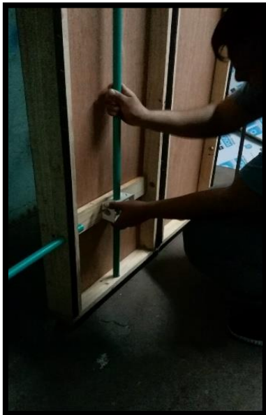
Figura 32 Instalación redes eléctricas verticales.
