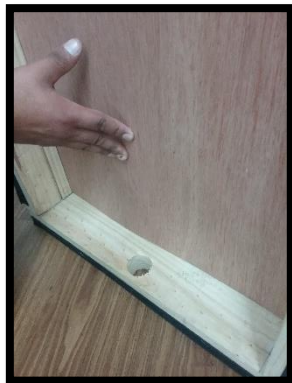
Figura 21 Perforación listón horizontal
