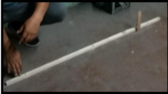
Figura 30 Instalación riel inferior.
