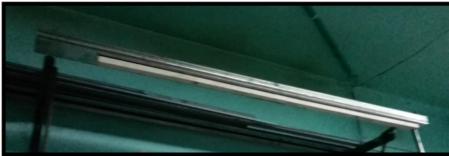
Figura 31 Instalación riel superior sobre placa simulada.
