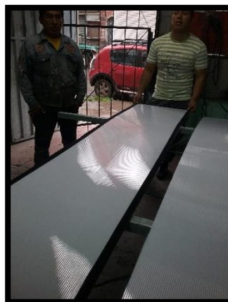
Figura 27 Instalación velcro a la lámina de policarbonato alveolar
