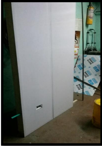
Figura 33 Acabado final de revestimiento de lámina policarbonato alveolar.
