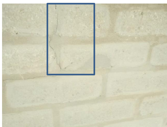
Ilustración 22 Fotografías desprendimientos y fisuras
