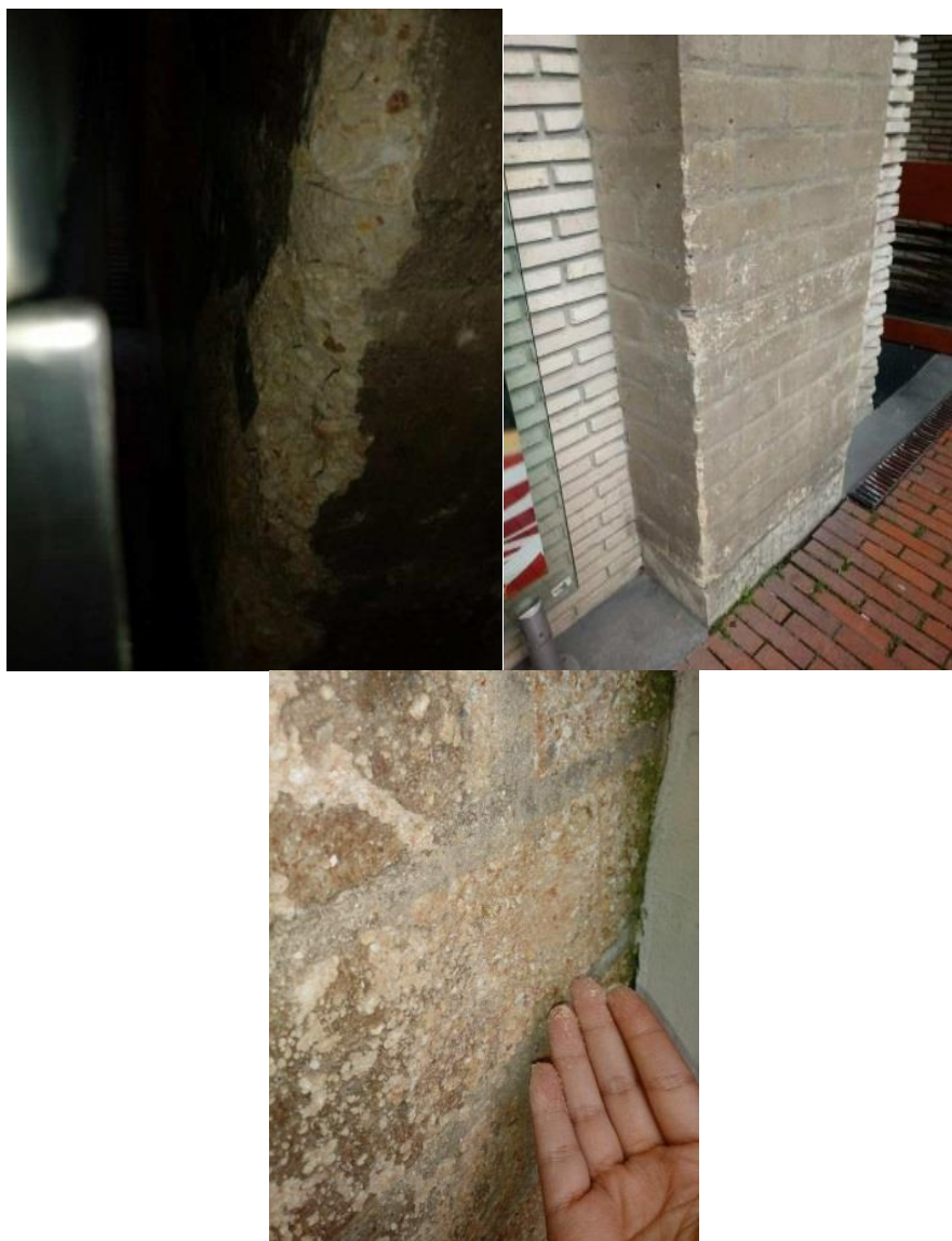
Ilustración 26 Fotografías erosión y Desprendimientos
