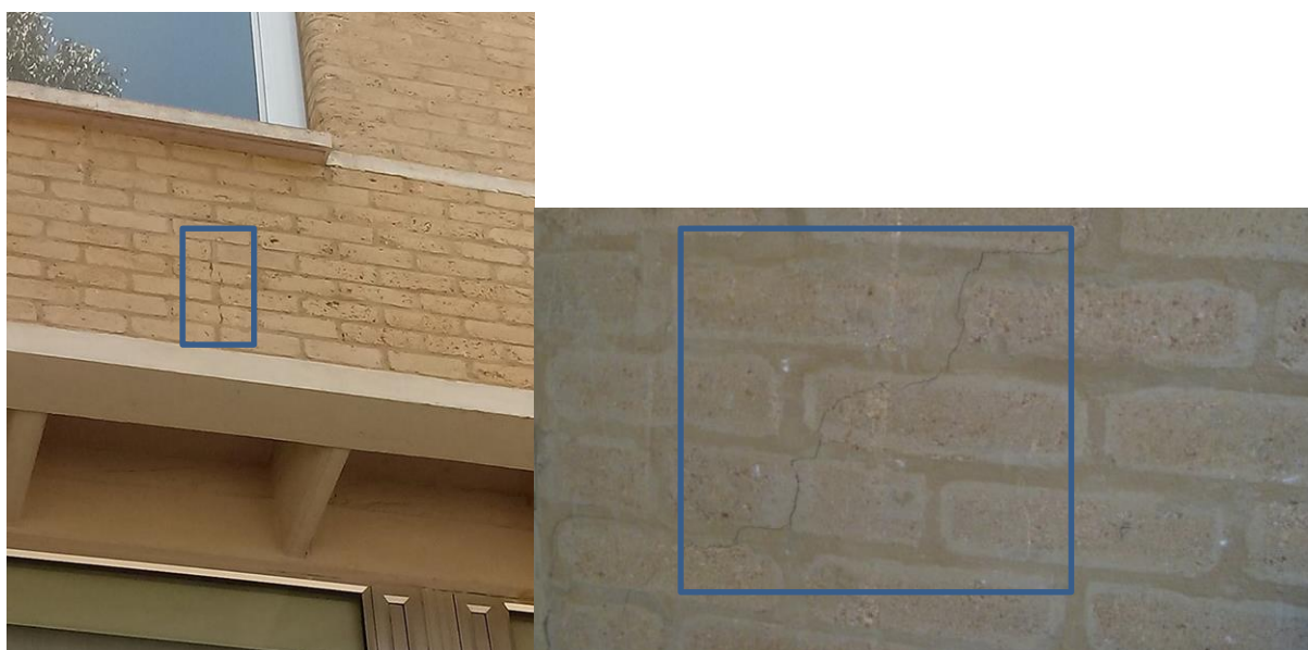
Ilustración 20 Fotografía fisuras
