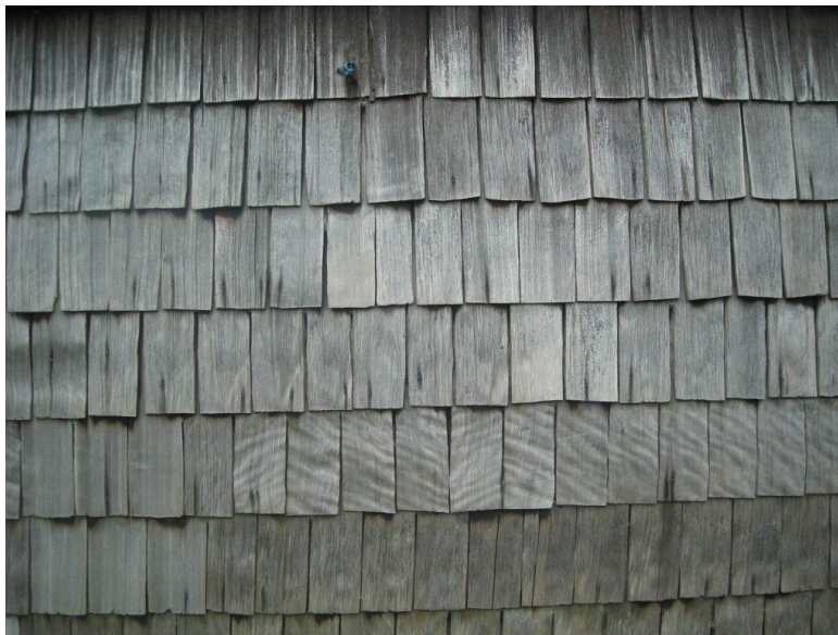
Ilustración 6 Tejas en madera, con lesión de fotodegradación
