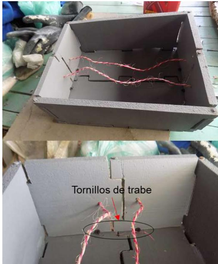
**Figura 29** Cuerda para desencofrado y ubicación de tornillos de trabe Fuente: Propia.
