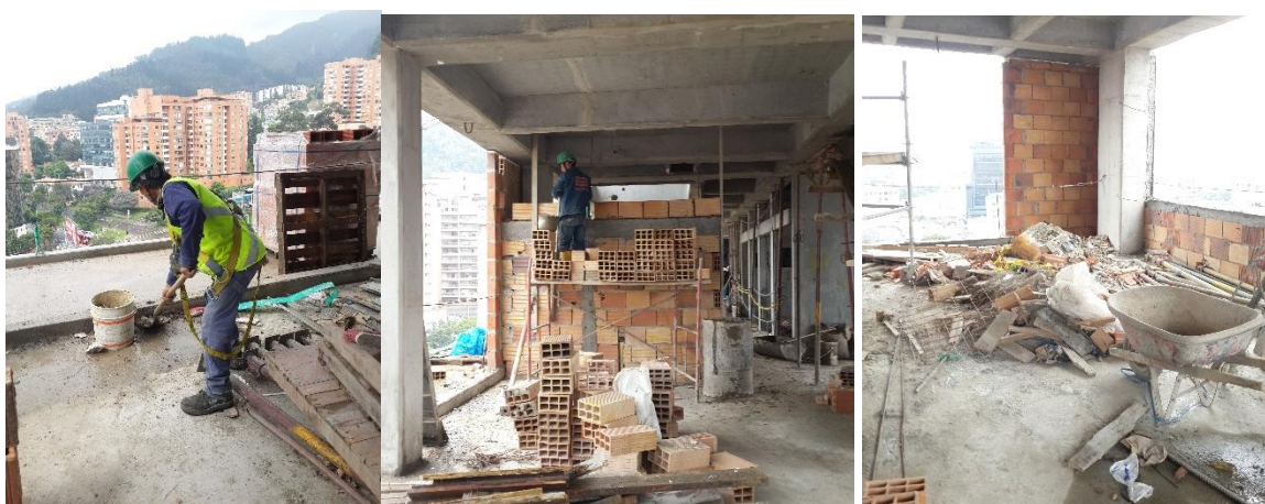
Figura 43. Operarios limpiando y en ejecución a más de 1.50, acopio de desperdicios.
