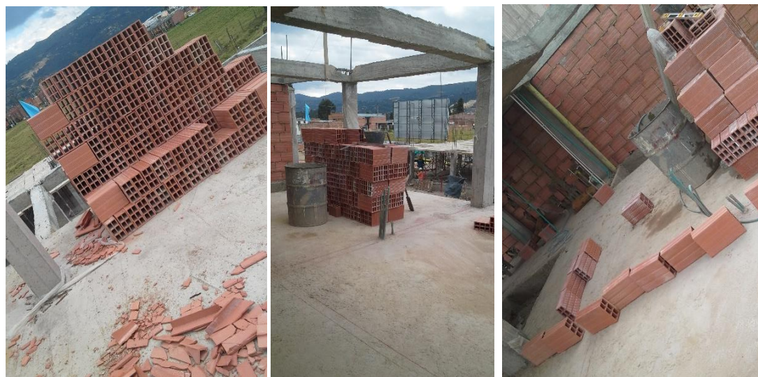
Figura 23. Mampuestos previamente apilados y dispuestos, antes de su disposición en húmedo. Fuente: Autor.
