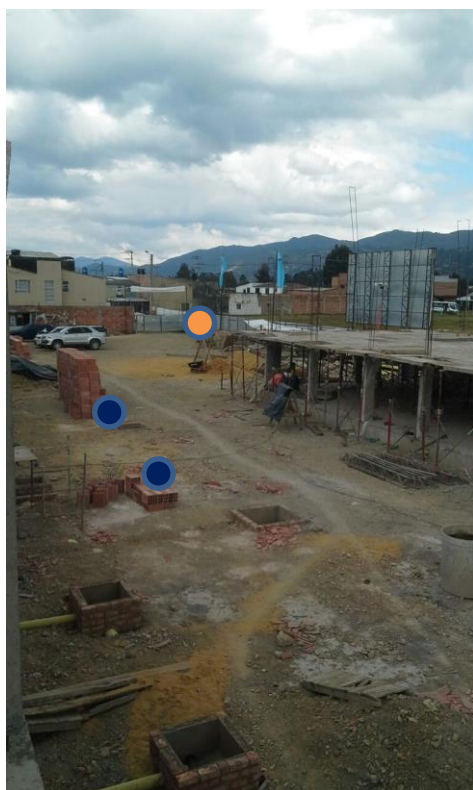
Figura 29. Disposición del mampuesto una vez llegado a obra
