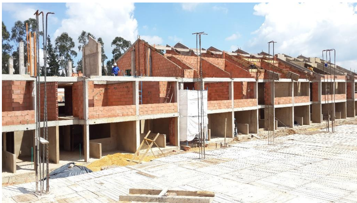
Figura 21. Actividad de mampostería, febrero 26 de 2018. Fuente: Autor.
