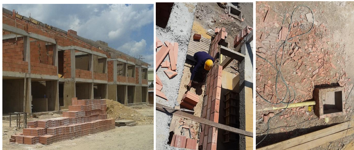
Figura 24. Apilamiento, disposición y desperdicios de mampuestos en la actividad Fuente: Autor
