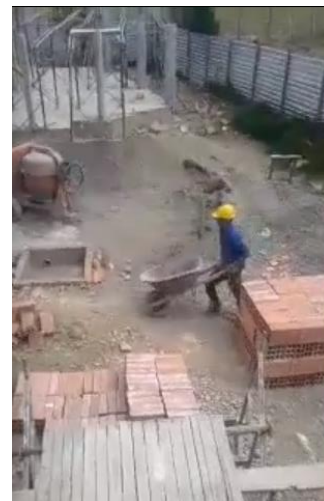
Figura 30. Operario transportando mampuestos del lugar dispuesto por el proveedor Fuete: Autor
