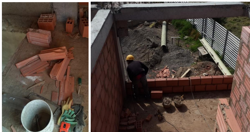
Figura 25. Desperdicio de piezas por modulaciones no especificadas y lugar de trabajo. Fuente: Auto.
