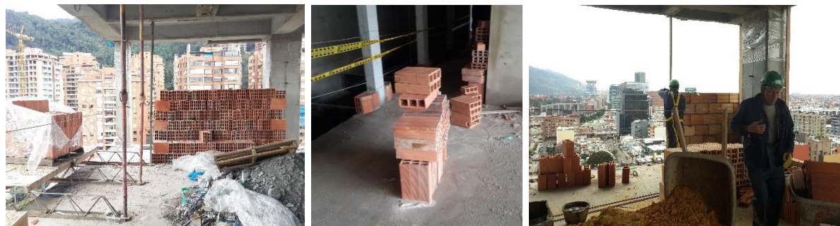
Figura 42. Acopio de insumos y disposición, lugar de ejecución
