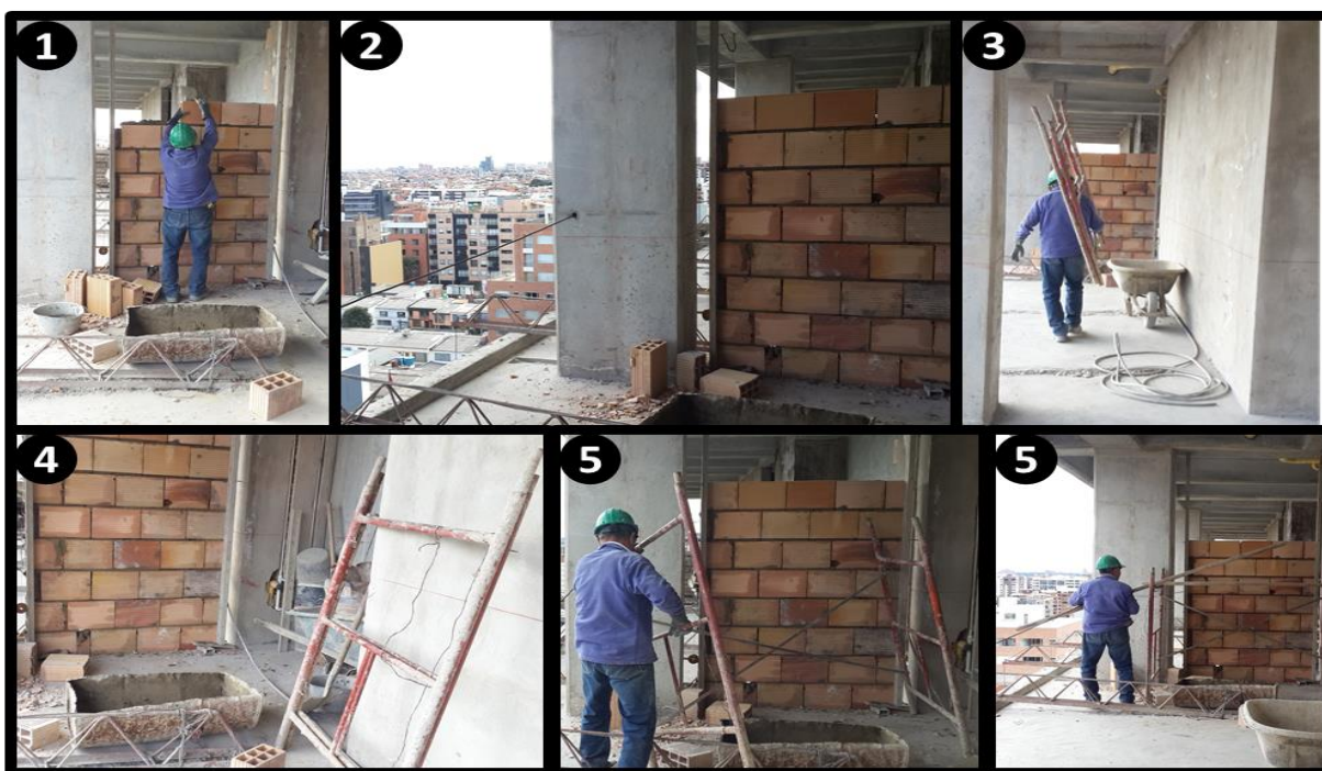
Figura 35. Ejecución a más de 1.5 m, Abril 23. Fuente: Autor
