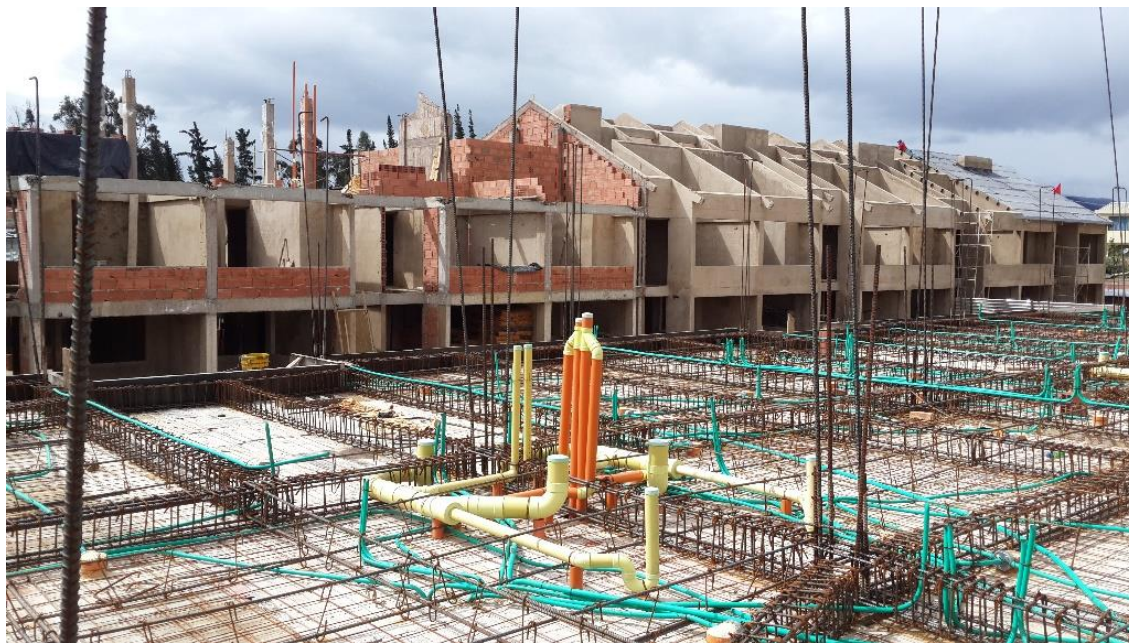
Figura 22. Actividad de mampostería, abril 18 de 2018.
