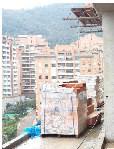
Figura 40. Mampuestos dispuestos para la actividad.
