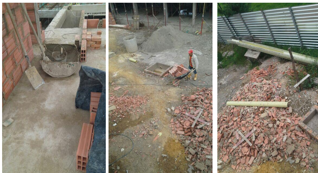
Figura 26. Lugar de trabajo, desplazamiento de mampuestos y desperdicios de los mimos. Fuente: Autor.
