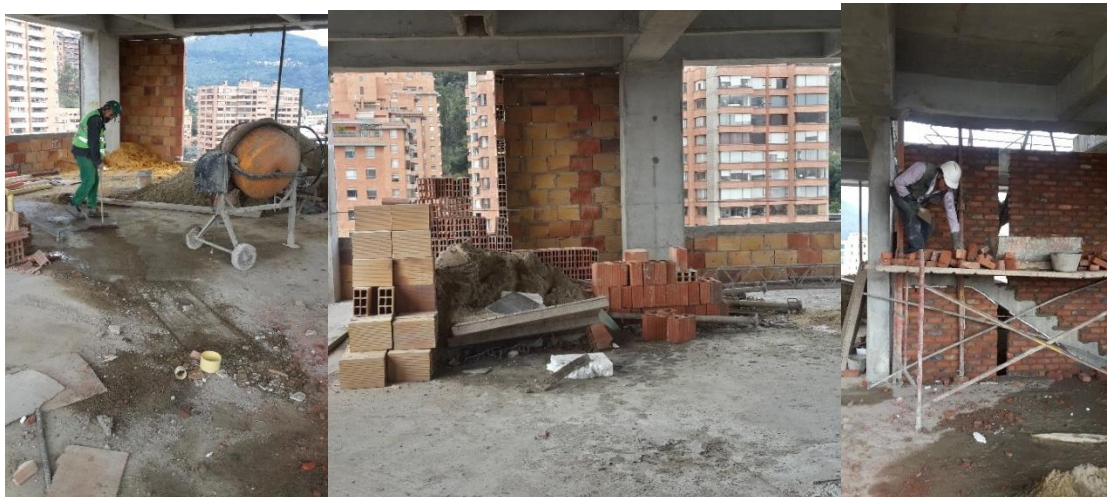
Figura 45. Ejecución de aseo, apilamiento de mampuestos y ejecución sobre andamios.
