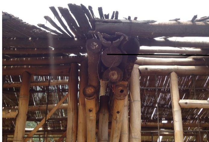
Ilustración 55. Incendio en cercha y correas. Fuente: Fotografía propia.
