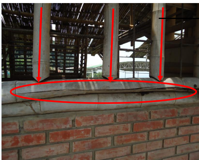
Ilustración 48. Aplastamiento ventana. Fuente Fotografía propia.
