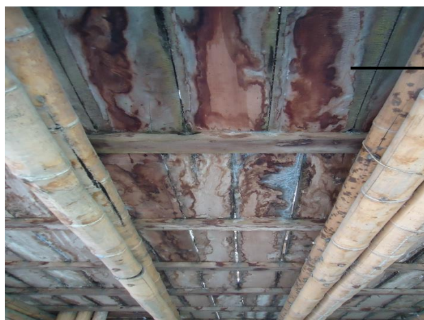
Ilustración 56. Hongos de pudrición y moho. Fuente: Fotografía propia.
