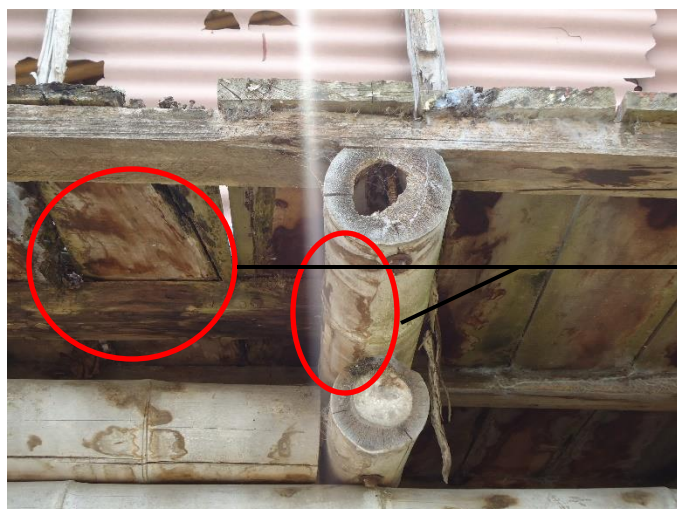
Ilustración 54. Humedad entrepiso y vigas. Fuente: Fotografía propia.
