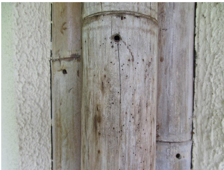
Ilustración 11. Perforaciones por Coleópteros y Fotodegradación. Fuente: Walter Barreto.
