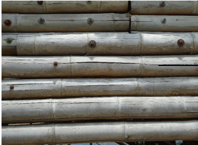
Ilustración 53. Fotodegradación y fisuras. Fuente: Fotografía propia.
