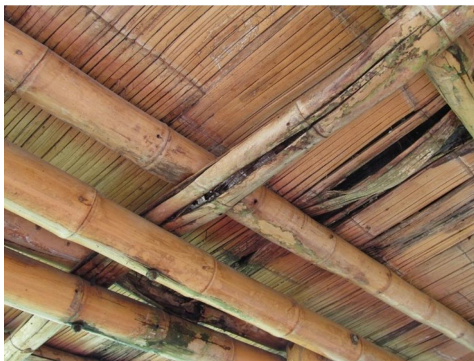
Ilustración 14. Falla por flexión luego de perder sección por pudrición. Fuente: Walter Barreto 2017.
