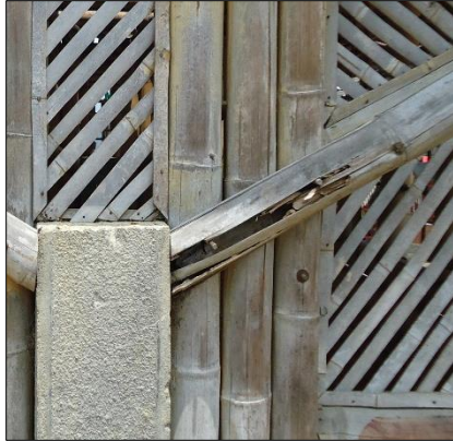
Ilustración 59. Detalle propuesto para la protección del elemento. Fuente: Elaboración propia.
