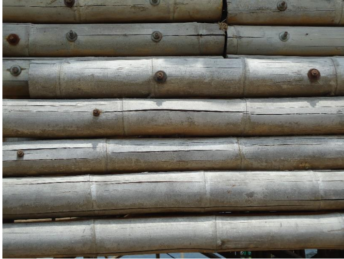
Ilustración 8. Fotodegradación en la guadua. Fuente: Fotografía propia.
