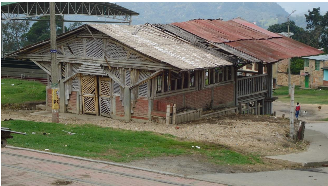
Ilustración 46. Foto general de la vivienda. Fuente: Imagen propia.
