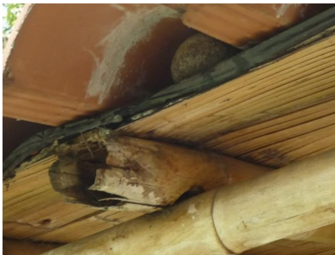
Ilustración 13. Aplastamiento por compresión luego de perder sección por pudrición. Fuente: Walter Barreto 2017.
