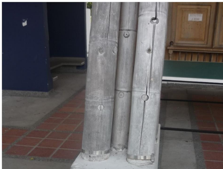
Ilustración 12. Fotodegradación y agrietamiento por tensiones diferenciales en la superficie. Fuente: Walter Barreto 2017.
