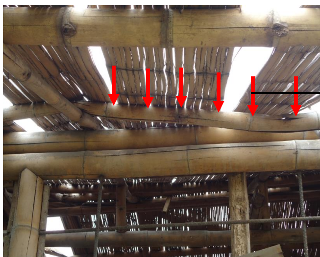
Ilustración 50. Deflexión en correas. Fuente: Fotografía propia.
