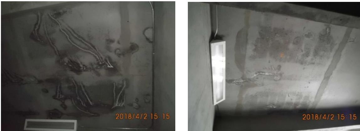
Figura 8 Humedad, filtraciones – Fuente Propia
