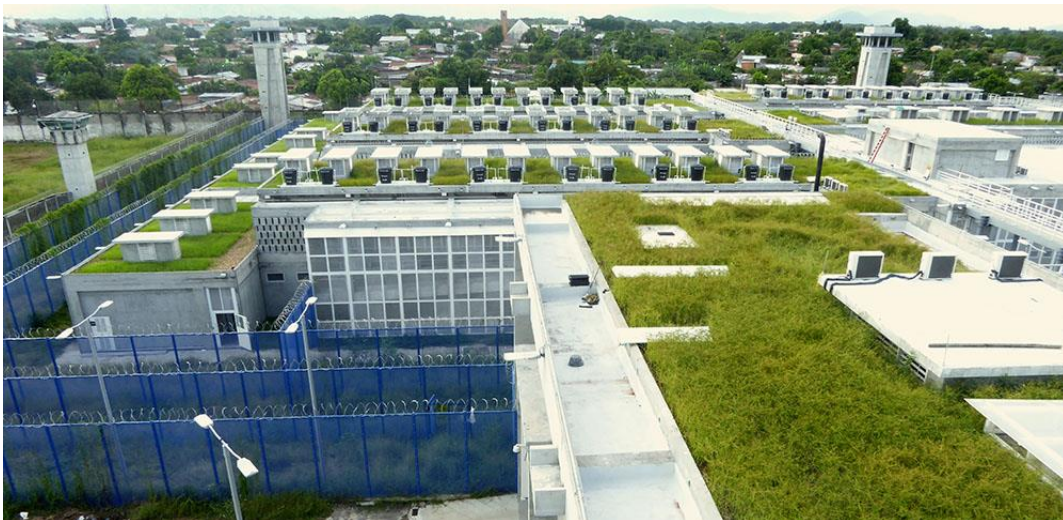
Figura 13 Estructura Cubierta del CPMS Espinal – Fuente USPEC
