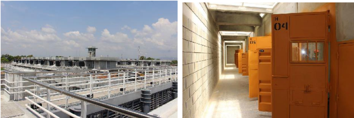
Figura 5 Estructura Cubierta y Celdas del CPMS Espinal – Fuente USPEC.
