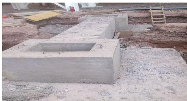
Figura No.9. Se aprecia una de las zapatas (cimentación superficial) en la construcción del centro de justicia de Chihuahua. (Fuente Propia).
