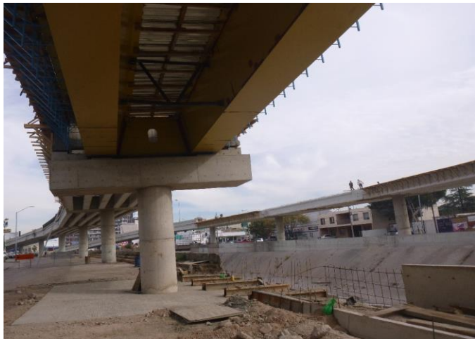
Figura No.6. Se evidencia la obra civil de los puentes gemelos, en donde claramente se ve que está aún en construcción. (Fuente Propia).
