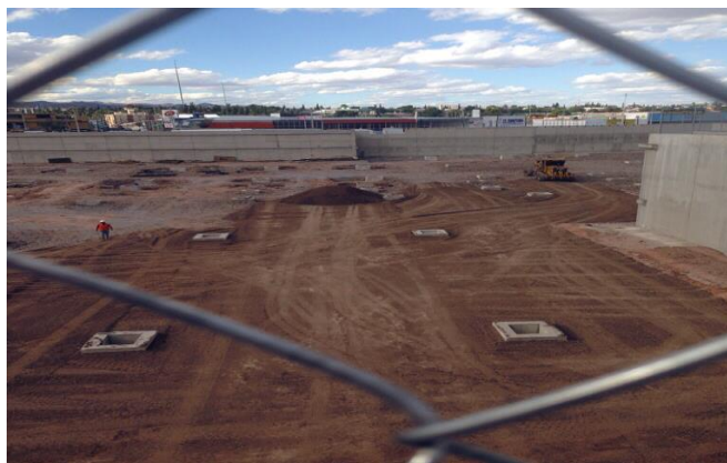
Figura No.8. Se aprecian claramente los cimientos superficiales (Zapatas) en la construcción del centro de justicia de Chihuahua. Al igual se ve que el suelo de superficie presenta características áridas. (Fuente: http://www.skyscrapercity.com/showthread.php?t=1625101 ).
