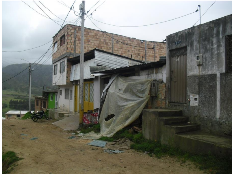
Figura 25: Imagen de las construcciones típicas del barrio AJS-III
