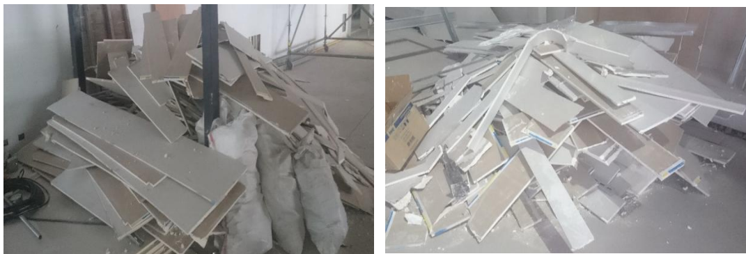
Imagen 10. Residuo de placas de yeso laminado en obra. Fuente: Elaboración Nicolás Garzón y Cesar Triana.
