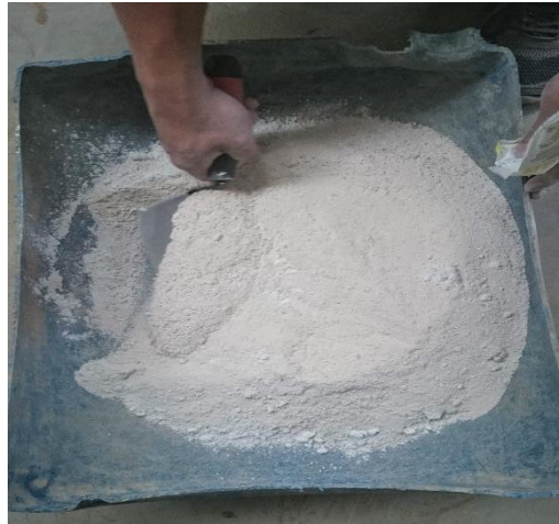
Imagen 18. Homogeneización de la mezcla y adición de agua para compactar. Fuente: Elaboración Nicolás Garzón y Cesar Triana.
