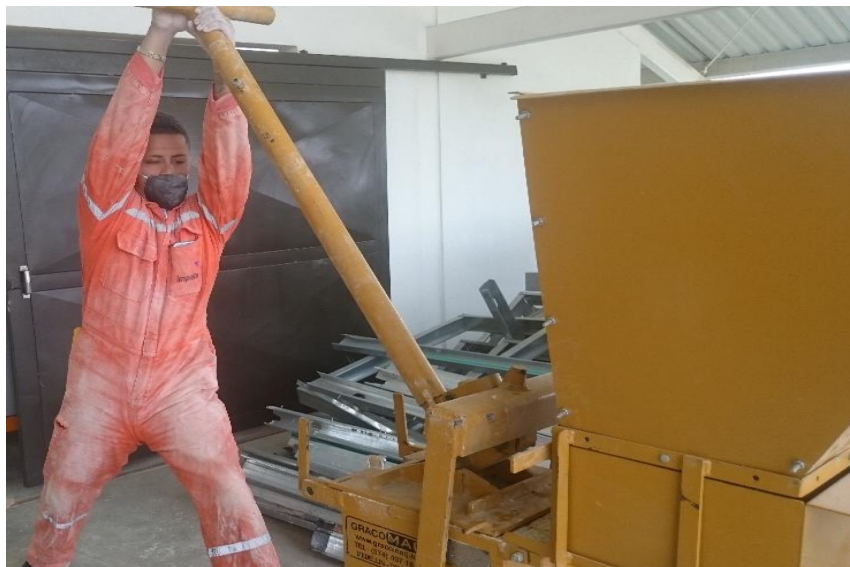
Imagen 19. Cargue de la Cinva-Ram y compactación de la mezcla. Fuente: Elaboración Nicolás Garzón y Cesar Triana.
