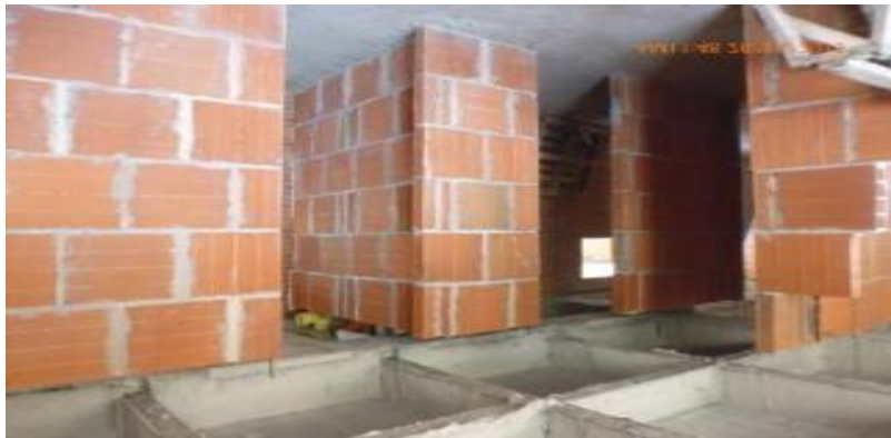
Imagen 7 . Muros divisorios no estructurales. Fuente: https://goo.gl/hn4N6a
