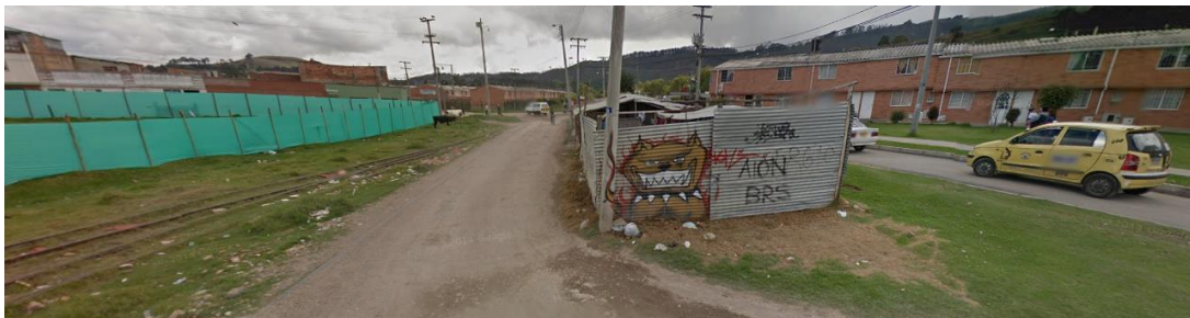
Figura 35: Imagen de vivienda existente sobre inmediaciones de la línea férrea
