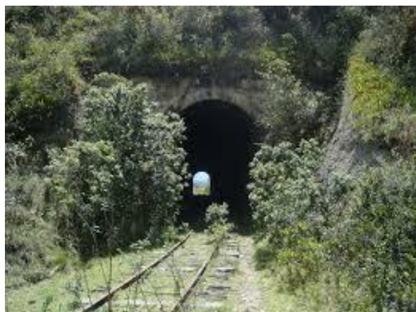
Figura 22: Imagen Túnel del Ferrocarril
