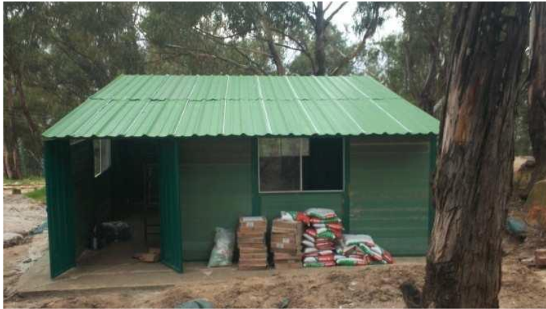
Figura 5. Estructura en Sogamoso
