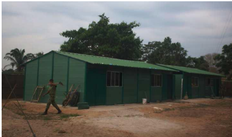
Figura 6. Estructura en Arauca
