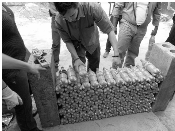
Figura19: Cimentación ciclópea con botellas PET
