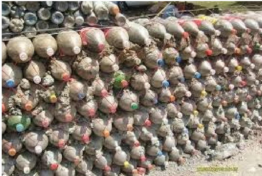
Figura18: Muros elaborados con botellas de bebidas gaseosas rellenas de cal-tierra
