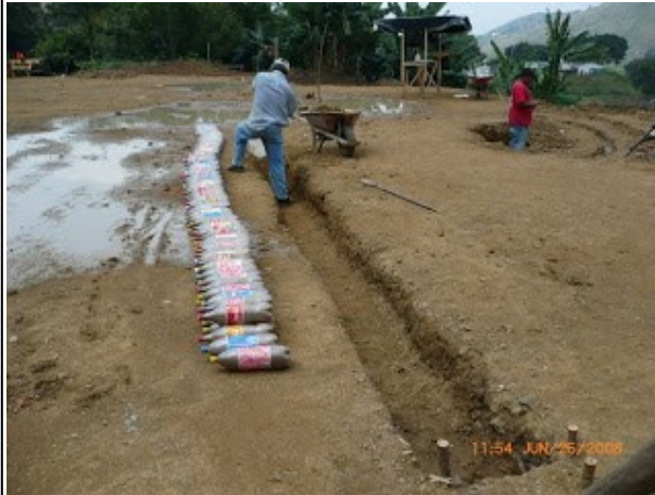
Figura 21: Proceso de empleo de las botellas para la cimentación
