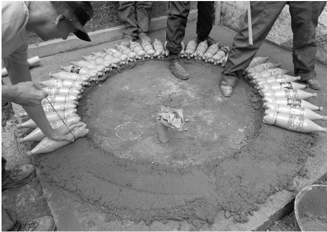
Figura20: Cimentación corrida con plástico PET
