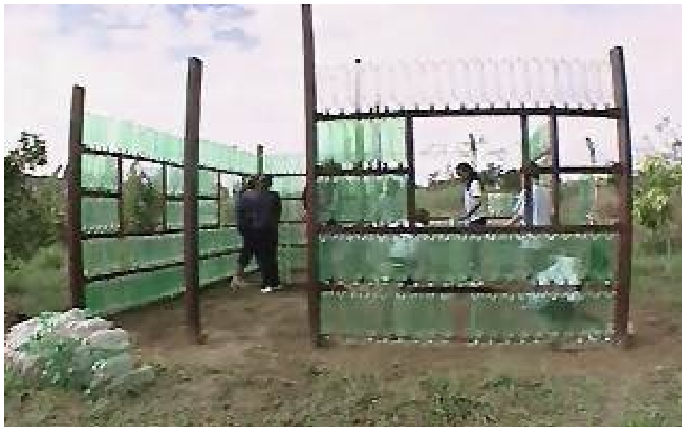
Figura 17: construcción de una vivienda con botellas recicladas sin procesar
