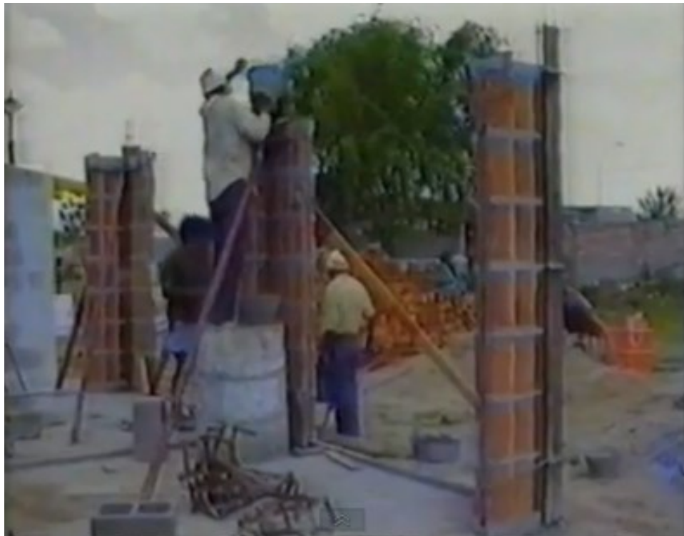
Figura 35: Fundida de manera vertical
