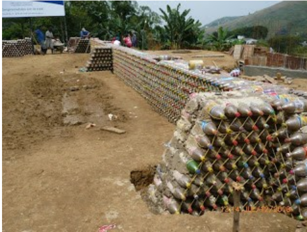
Figura 22: cimiento muros y refuerzos
