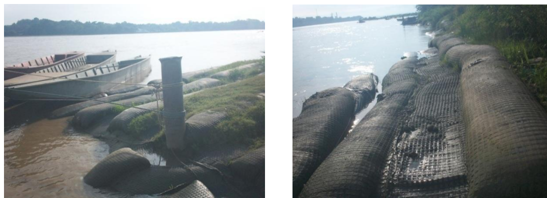
Figura 18 Estado actual del Malecón de Puerto Boyacá
