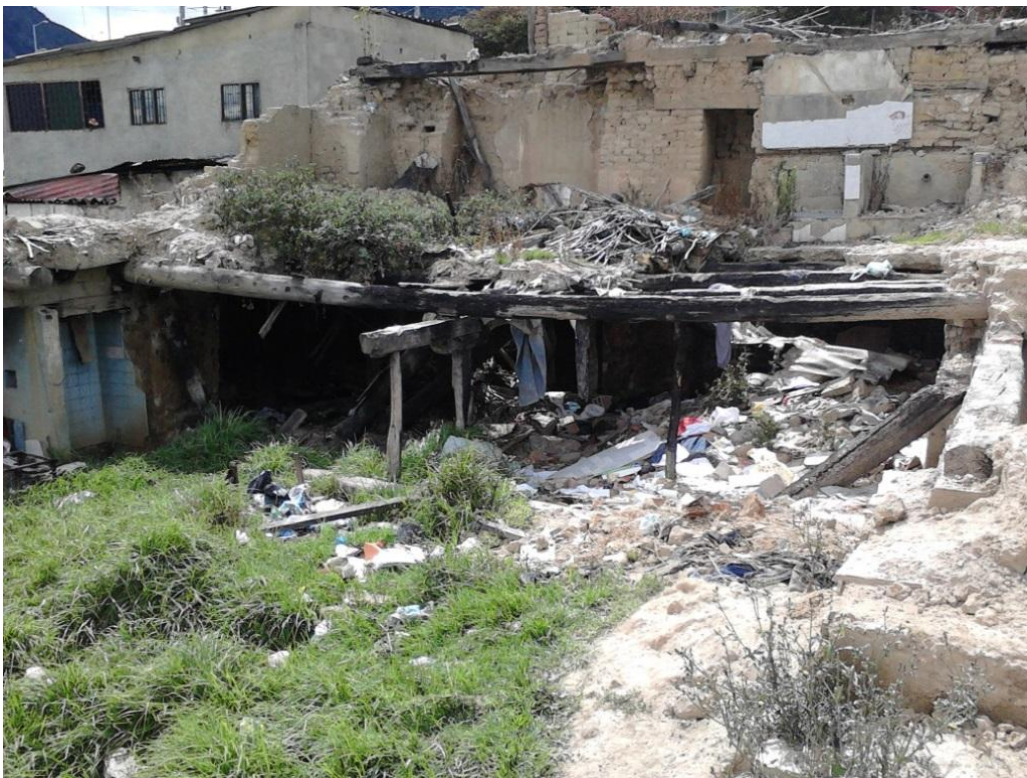
Imagen N° 1 Ruinas ala norte de la Antigua Fábrica de Loza, costado Oriental
