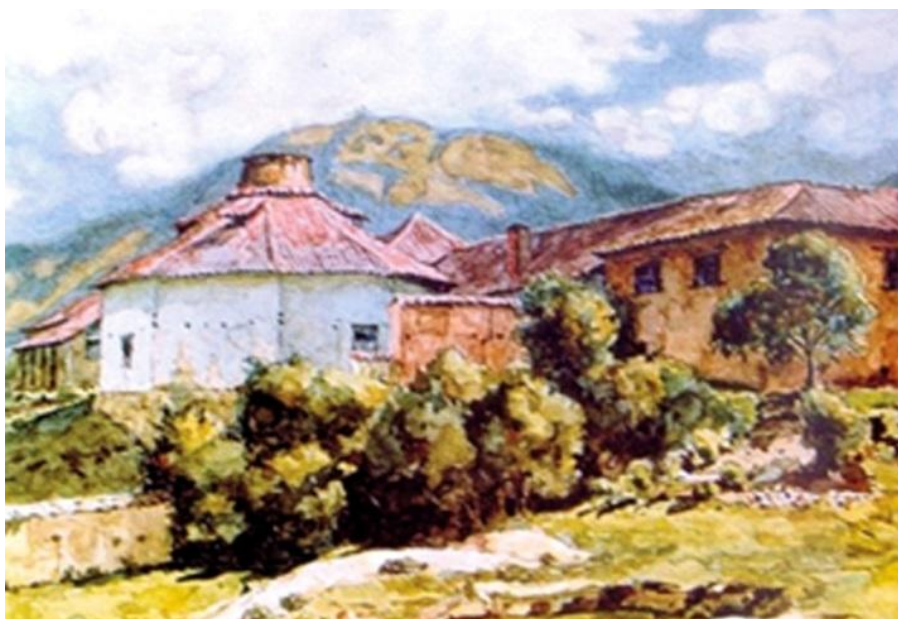
Imagen N° 9 Acuarela de la fábrica en dirección suroccidente – nororiental. Se observa en primer plano el cerramiento en tapia pisada que rodea la fábrica, y, en este, una parte del edificio, con un horno cubierto por una estructura hexagonal, depósitos y departamentos de producción (Ricardo Mora Urbina, Antigua Fábrica de Loza, 1906. Acuarela y lápiz/ papel, 20,3 x 30 cm. Museo Nacional de Colombia).
