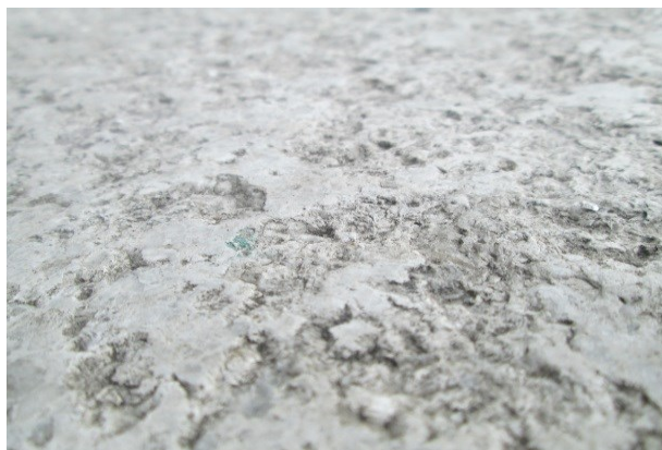
Figura 37. Deterioro piso pista de patinaje.
