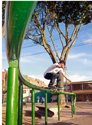
Figura 48. Baranda deteriorada por la destreza de este deporte quitándole vida útil a material. Adaptada de
