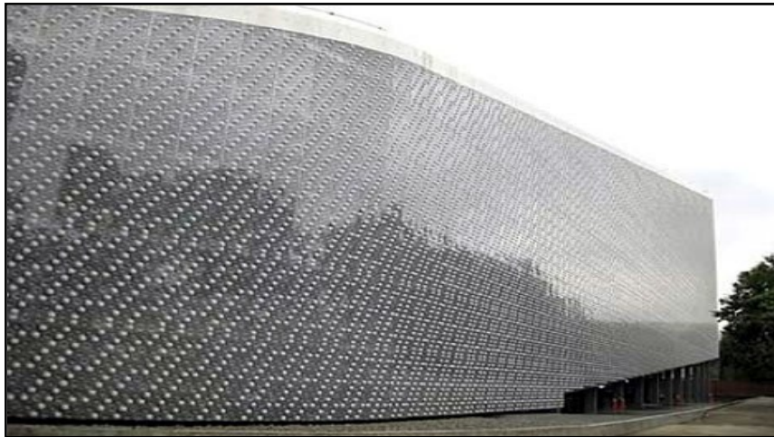
Figura 6. Edificio construido con PET reciclado.
