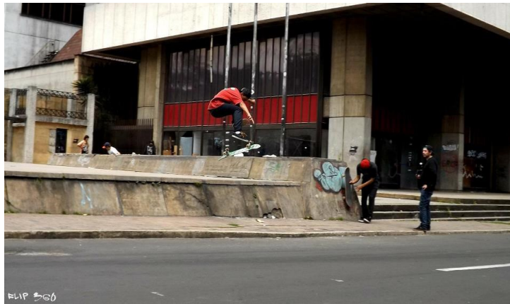
Figura 30. Las losas deterioradas por practicantes de skateboarding. Adaptado de http://snickersla.wordpress.com/tag/skate/
