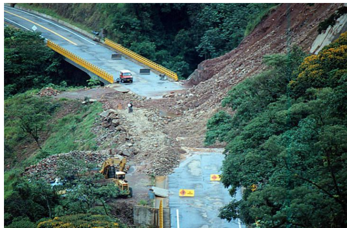
Imagen 1. Vía a Villavicencio es una de las más afectadas por la presencia de rocas lodosas, que terminan causando derrumbes. Archivo El Tiempo.
