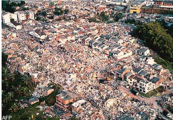
Imagen 3. Terremoto de Armenia-1999. Fuente: Blog El Tormento de Armenia. http://www.caretas.com.pe/1999/1553/terremoto/terremoto.htm
