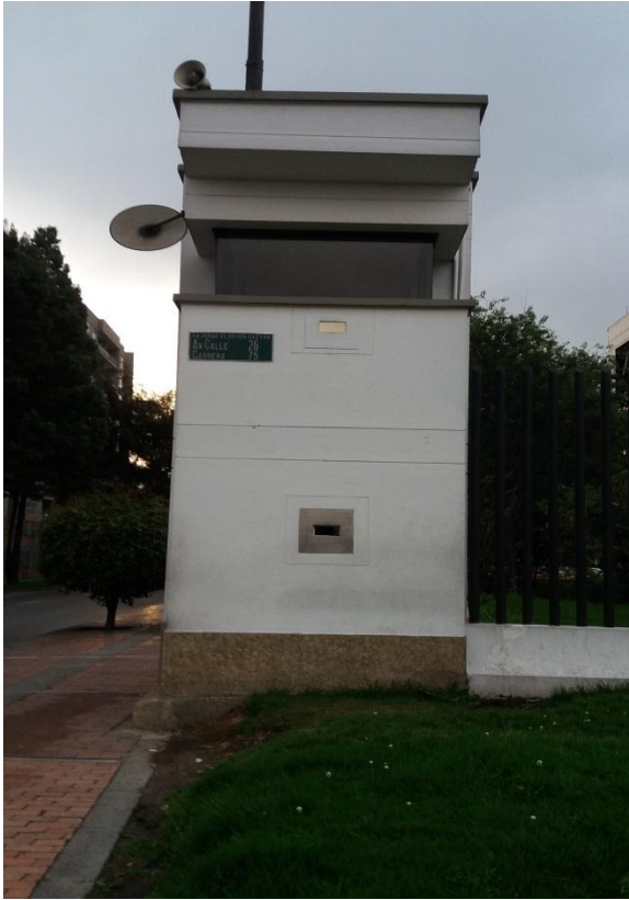
Imagen 3: Plano general en donde se evidencia la garita donde presta vigilancia el soldado.
