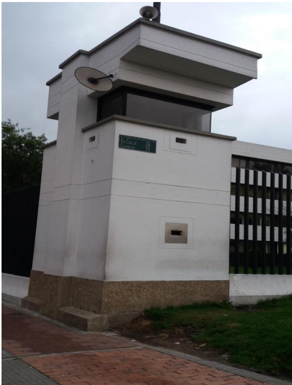
Imagen 4: Plano General donde se evidencia el área de la garita.
