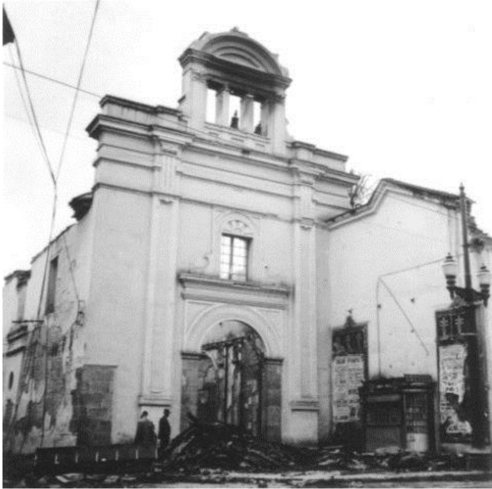
Fotografía del Hospicio de Bogotá destruido tomada por el periódico El Tiempo
