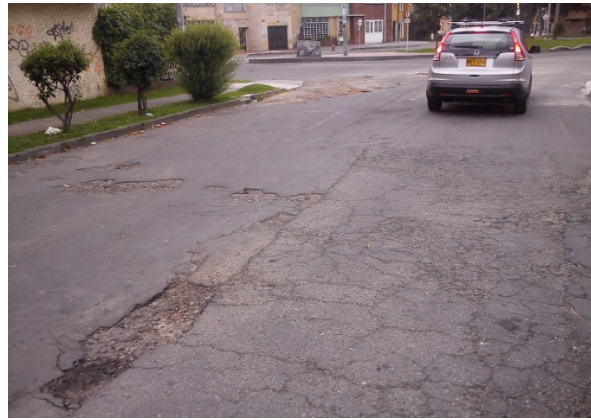
FOTO 5. Carrera 27 entre Calle 46 y Calle 47
