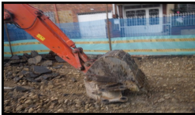
FOTO 21. Obras en ejecución Calle 45b con Carrera 20
