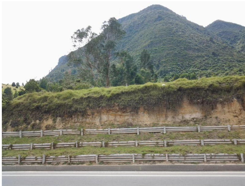
Fotografía 7. Trinchos de guadua como medida de control del Talud de la Vía Chía-Zipa Fuente: Propia
