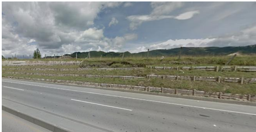
Fotografía 10. Taludes viales intervenidos con medidas bioingenieriles a lo largo del tramo Chía-Zipaquirá Fuente: Propia
