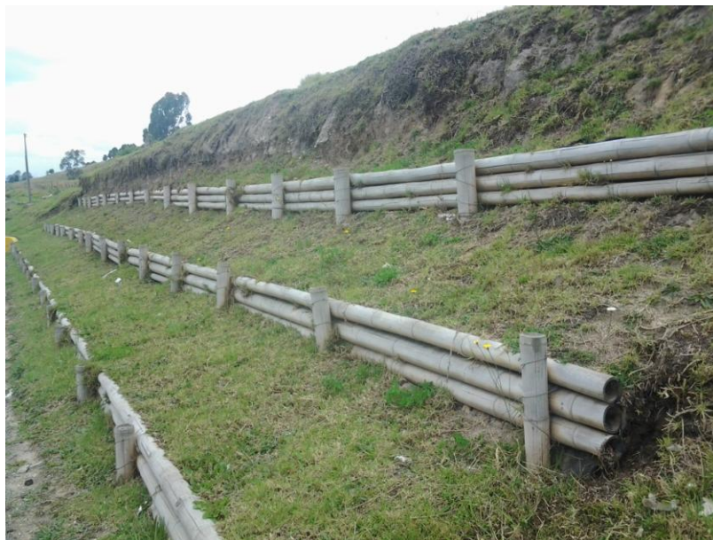
Fotografía 8. Vista de perfil de los trinchos de guadua y las terrazas del talud Fuente: Propia
