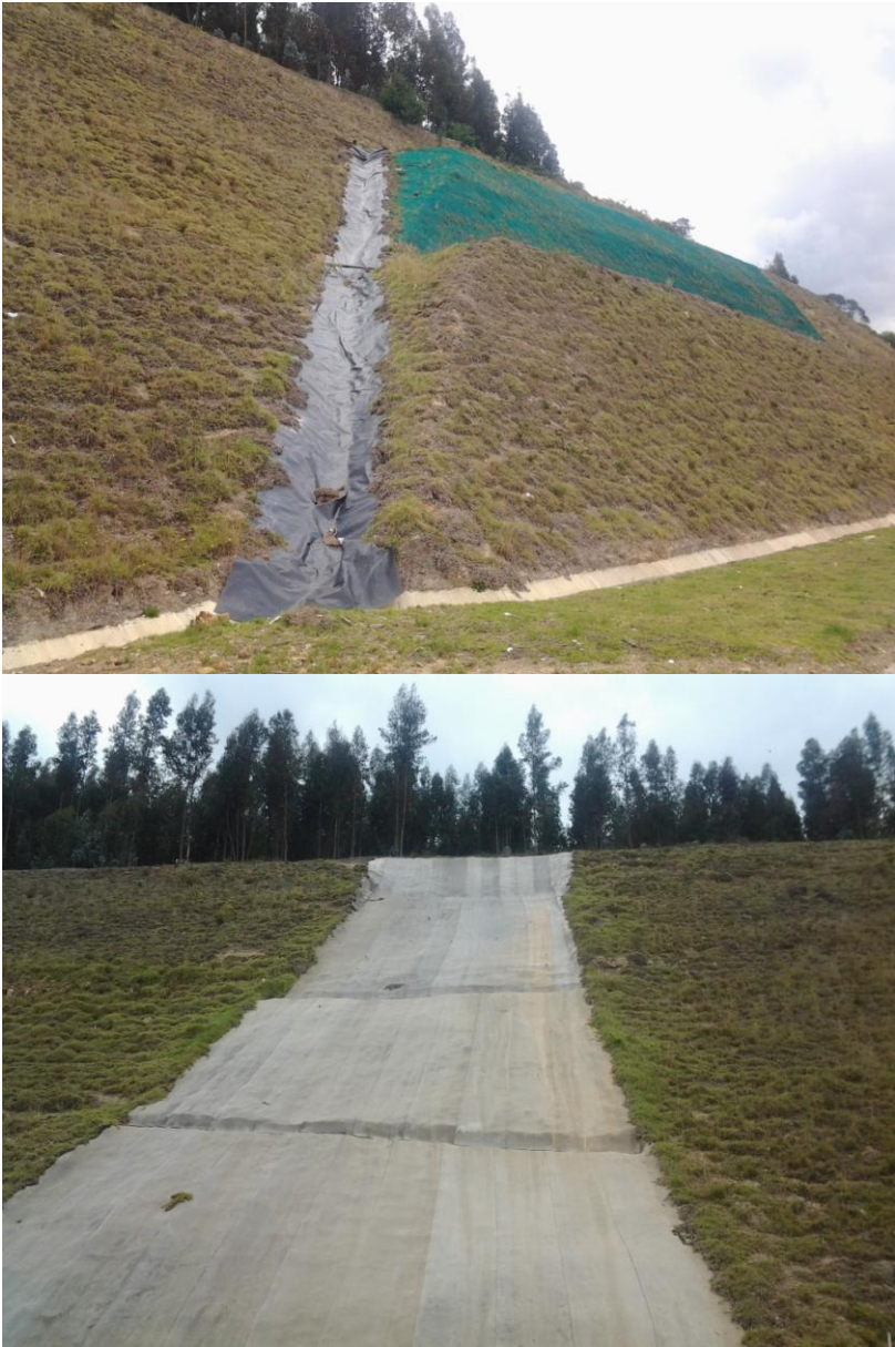
Figura 9. Uso de empradizados, geotextiles y geomallas para la estabilización y control de un talud vial en cercanías del municipio de Zipaquirá Fuente. Propia
