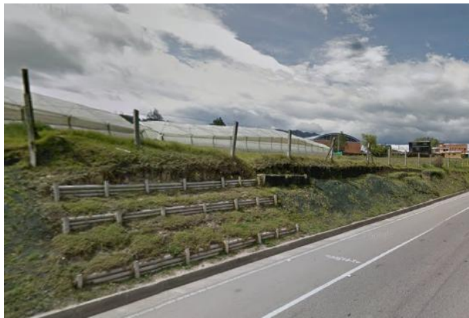
Fotografía 9. Trinchos de guadua combinados con Geotextiles para el control de Taludes viales sobre la variante de la vía Cajica-Zipaquirá Fuente: Propia
