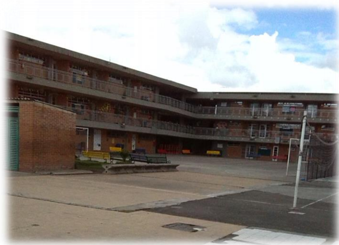
Fotografía 2. Vista interna Colegio Dintalito.
