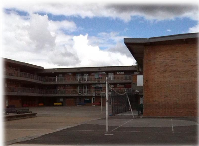
Fotografía 2. Vista interna Colegio Dintalito.
