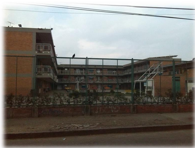
Fotografía No 3. Vista lateral Colegio Dintalito.
