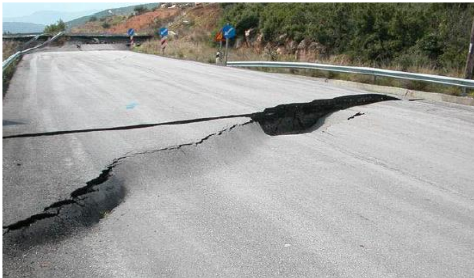
Figura 2. Falla de un terraplén bajo un pavimento.
