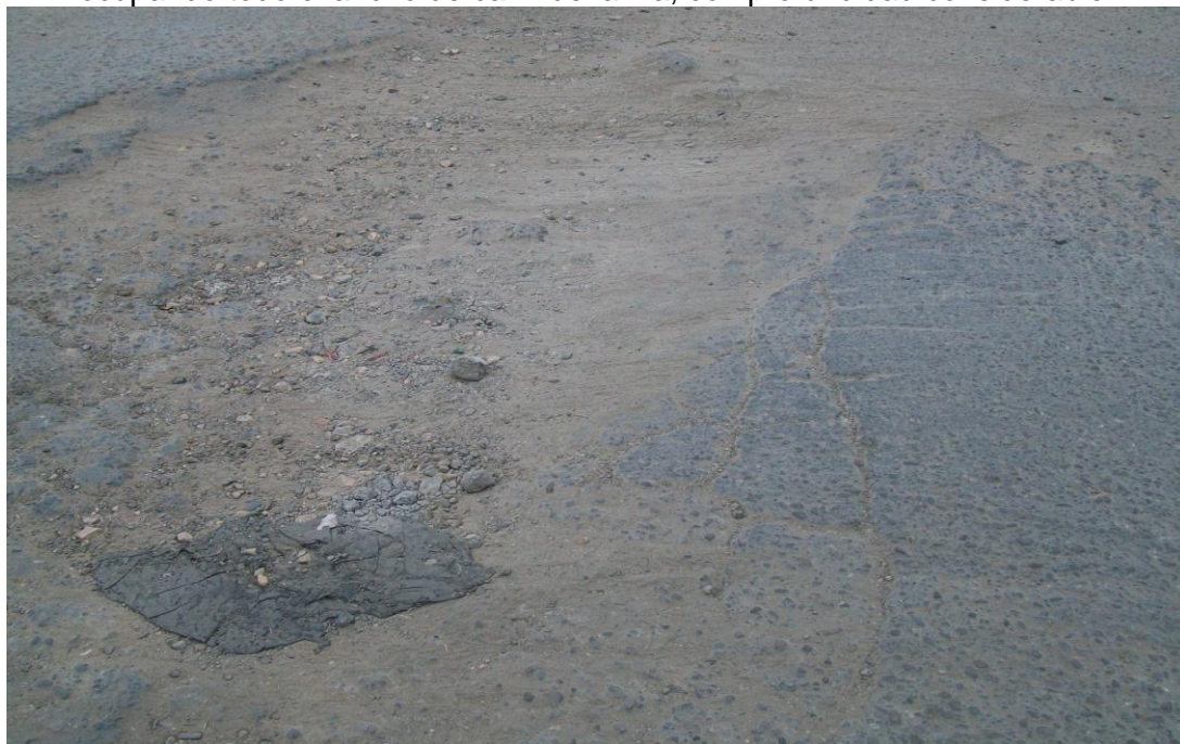
Figura 17. Bache profundo 1. Localizado en sentido perpendicular al eje de la vía. Bache ocupando todo el ancho de carril de la vía, con profundidad considerable.
