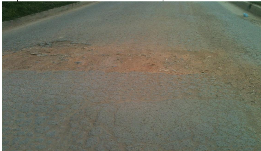
Figura 18. Bache profundo 2 localizado en sentido perpendicular al eje de la vía. Bache que ocupa todo el ancho de calzada de la vía con una profundidad bastante considerable.
