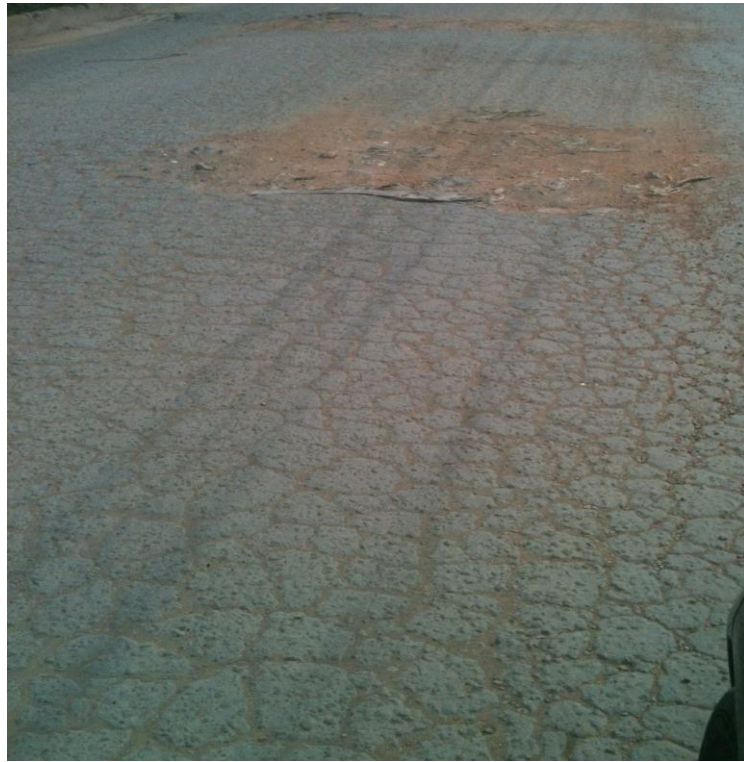
Figura 13. Tramo de vía con piel de Cocodrilo. En esta fotografía se presenta el deterioro de piel de cocodrilo pero con el agravante de pérdida de material.
