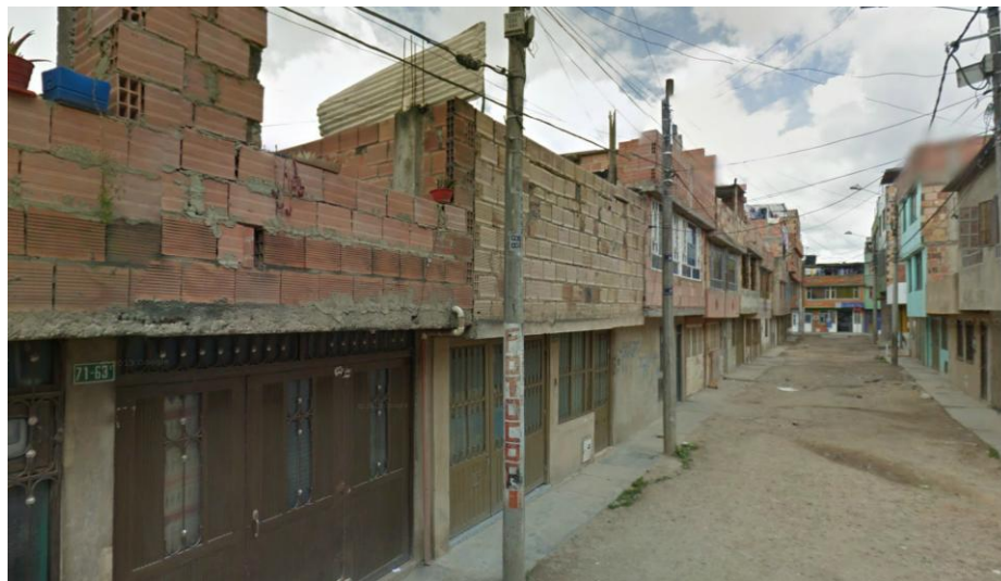
Imagen 6. Viviendas en construcción UPZ 87 -Tintal Sur-
